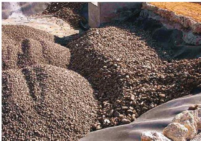
Figura 33. Recubrimiento de los drenes de evacuación con una capa de bolos de 50 – 100 mm. Imagen de Salas y otros (2007).
