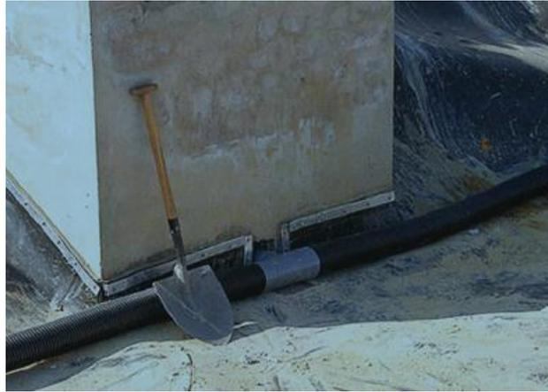
Figura 31. Detalle del enlace de las tuberías de drenaje con la tubería de evacuación a través del fondo de la arqueta de salida. Imagen del Salas y otros (2007).
