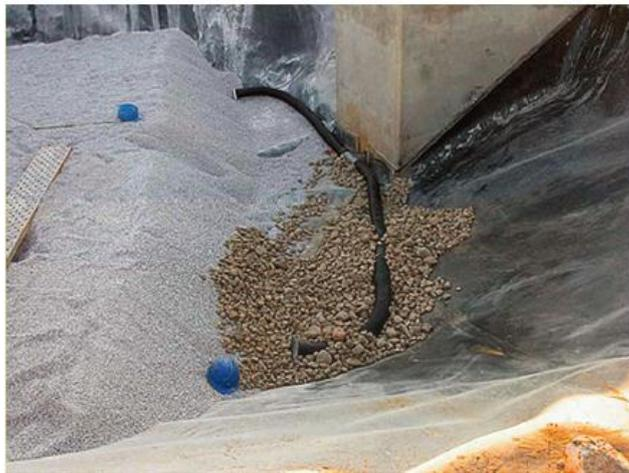
Figura 32. Tuberías de drenaje para la evacuación de efluentes en el HAFSs horizontal. Las tuberías quedan embutidas en una caja de bolos de 50 – 100 mm. Imagen del Salas y otros (2007).
