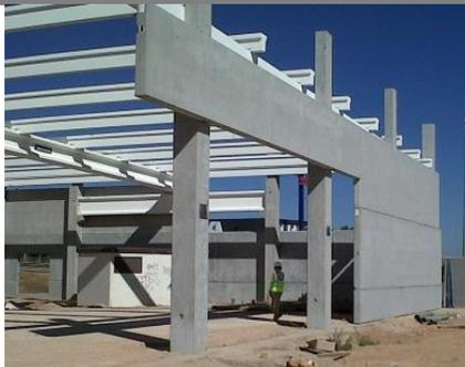
Ilustración 50. Colocación paneles horizontales. 2016. Fuente propia
