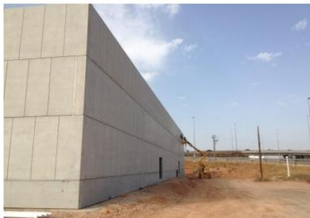
*Ilustración 49. Colocación paneles verticales. 2016. Fuente propia*
