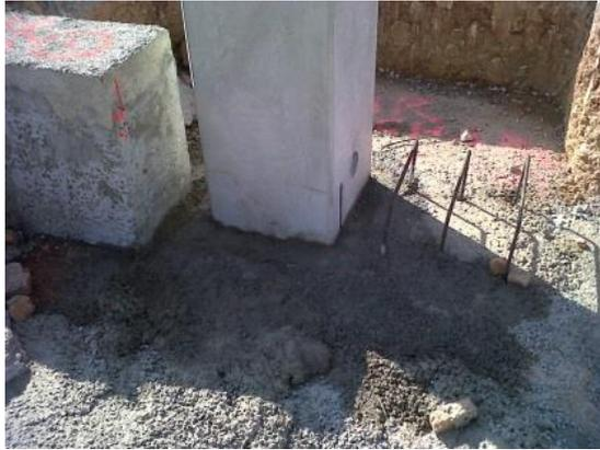
*Ilustración 36. Empotramiento del pilar e introducción de mortero grout. 2016. Fuente propia*
