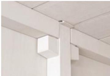
*Ilustración 38. Ménsulas en pilar con apoyo vigas rectangulares. 2016.
