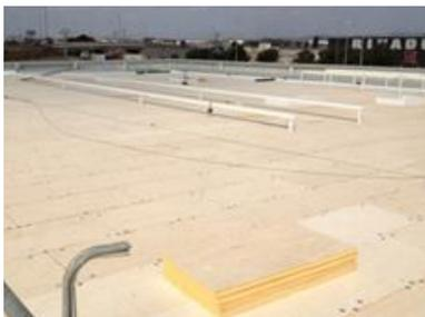
*Ilustración 69. Disposición del aislamiento lana de roca. 2016.
