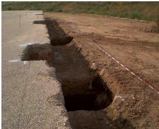
*Ilustración 34. Pozos zapatas aisladas. 2016.
