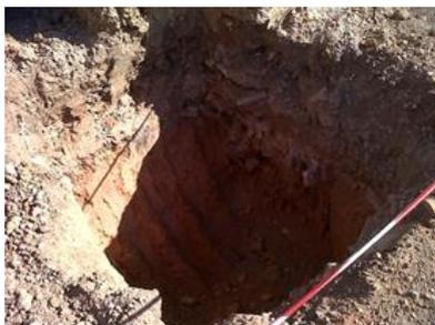
*Ilustración 56. Excavación zapata aislada. 2016. Fuente propia*
