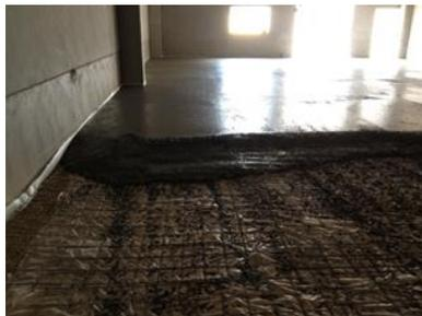
*Ilustración 73. Vertido del hormigón para solera. 2016. Fuente propia*
