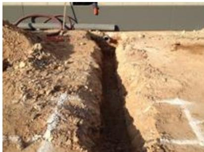
*Ilustración 55. Excavación riostras de atado. 2016. Fuente propia*
