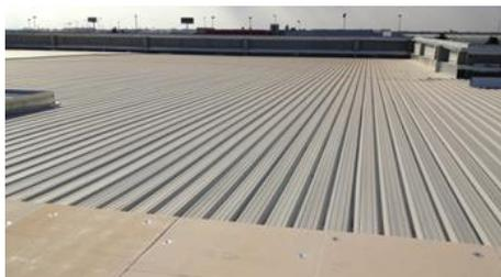
*Ilustración 68. Disposición de las chapas grecadas a lo largo de la cubierta. 2016.*
