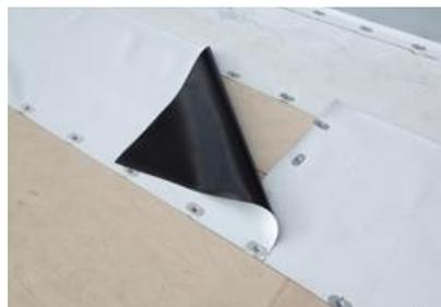
*Ilustración 70. Colocación de láminas impermeables sobre el aislamiento. 2016. Fuente propia*
