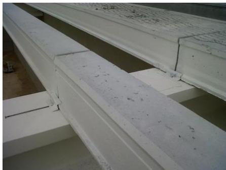
*Ilustración 44. Anclaje mecánico de correas a vigas principales. 2016. Fuente propia*
