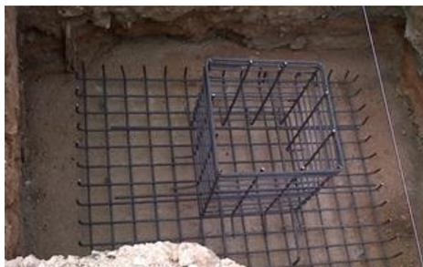
*Ilustración 57. Armadura parrilla inferior zapata y jaula para el cajón. 2016. Fuente propia*
