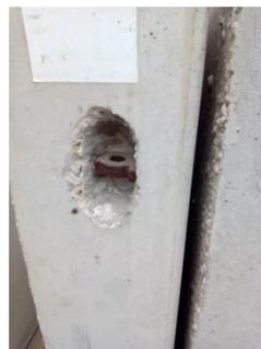
*Ilustración 24. Hendiduras para izado de pilares. 2016. Fuente propia*
