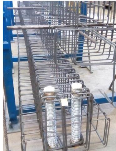
*Ilustración 30. Montaje armaduras de viga fuera del encofrado. 2016. Fuente propia*
