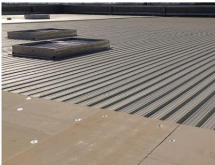
*Ilustración 46. Chapas metálicas, perfiles grecados. 2016. Fuente propia*
