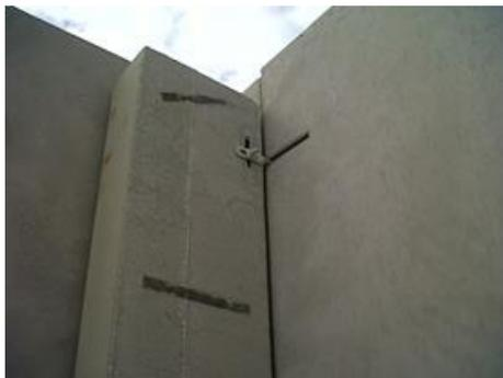
*Ilustración 66. Anclajes mecánicos Pilar y paneles de cerramiento. 2016. Fuente propia*
