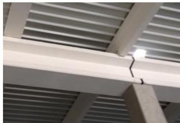
*Ilustración 40. Apoyo correas tubulares sobre viga principal. 2016. Fuente propia*
