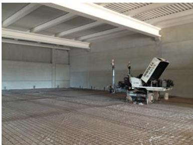
*Ilustración 72. Colocación mallazo en solera. 2016. Fuente propia*
