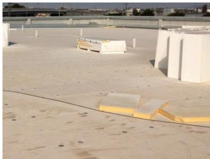
*Ilustración 45. Colocación aislamiento lana de roca. 2016. Fuente propia*
