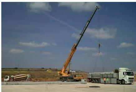
*Ilustración 59. Izado y descarga de pilares. 2016 Fuente propia*
