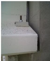
*Ilustración 39. Unión atornillada viga a ménsula de pilar. 2016. Fuente propia*
