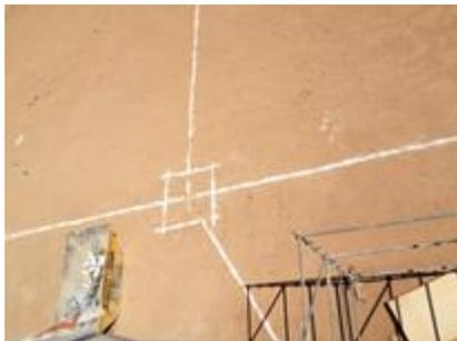
*Ilustración 54. Replanteo zapatas y riostras. 2016. Fuente propia*
