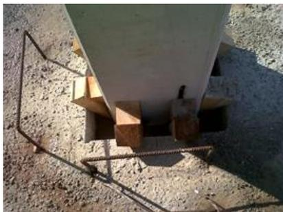
*Ilustración 61. Acuña de pilares con cuñas de madera. 2016. Fuente propia*
