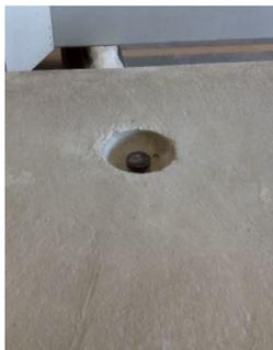
*Ilustración 25. Hendiduras para izado de pilares. 2016. Fuente propia*
