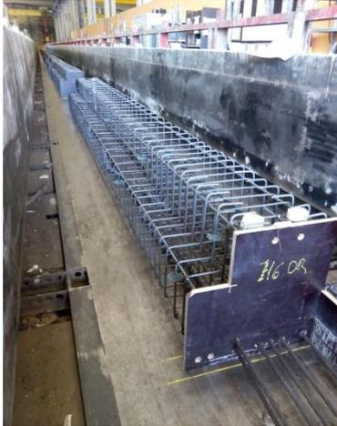
*Ilustración 31. Armaduras viga dentro del encofrado. 2016. Fuente propia*
