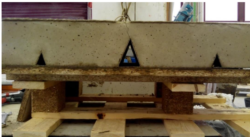
Figura 46. Aspecto de la probeta fisurada tras el ensayo.
