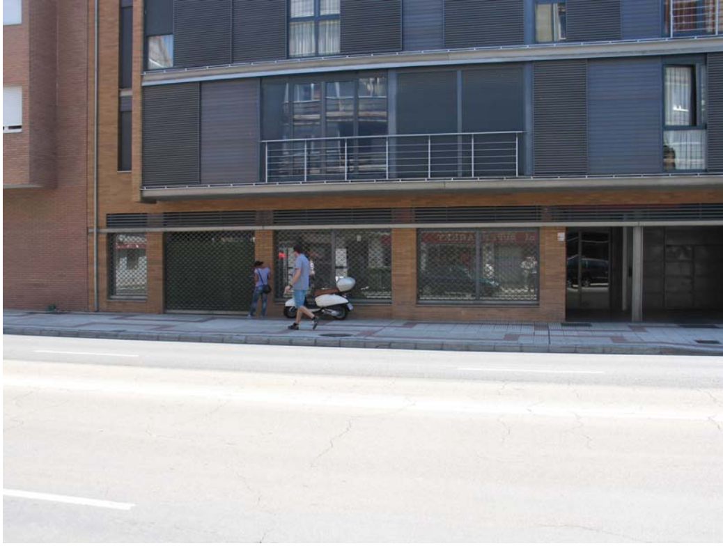
Fachada a la Avda. Doctor Fleming
