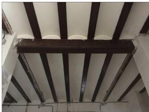
Ilustración 18. Estructura de forjado de revoltones. Autor propio
