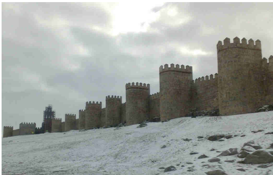
Figura 58. Murallas de Ávila, recientemente restauradas con cargo al 1 % Cultural. Año 2016. Fuente: elaboración propia
