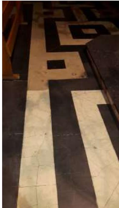
*Fig. 26 Agrietamiento del pavimento*
