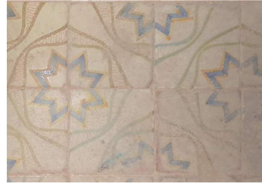
Ilustración 56. Pavimento cerámico pintado a mano sala 2DC, 2016. Fuente: Propio autor
