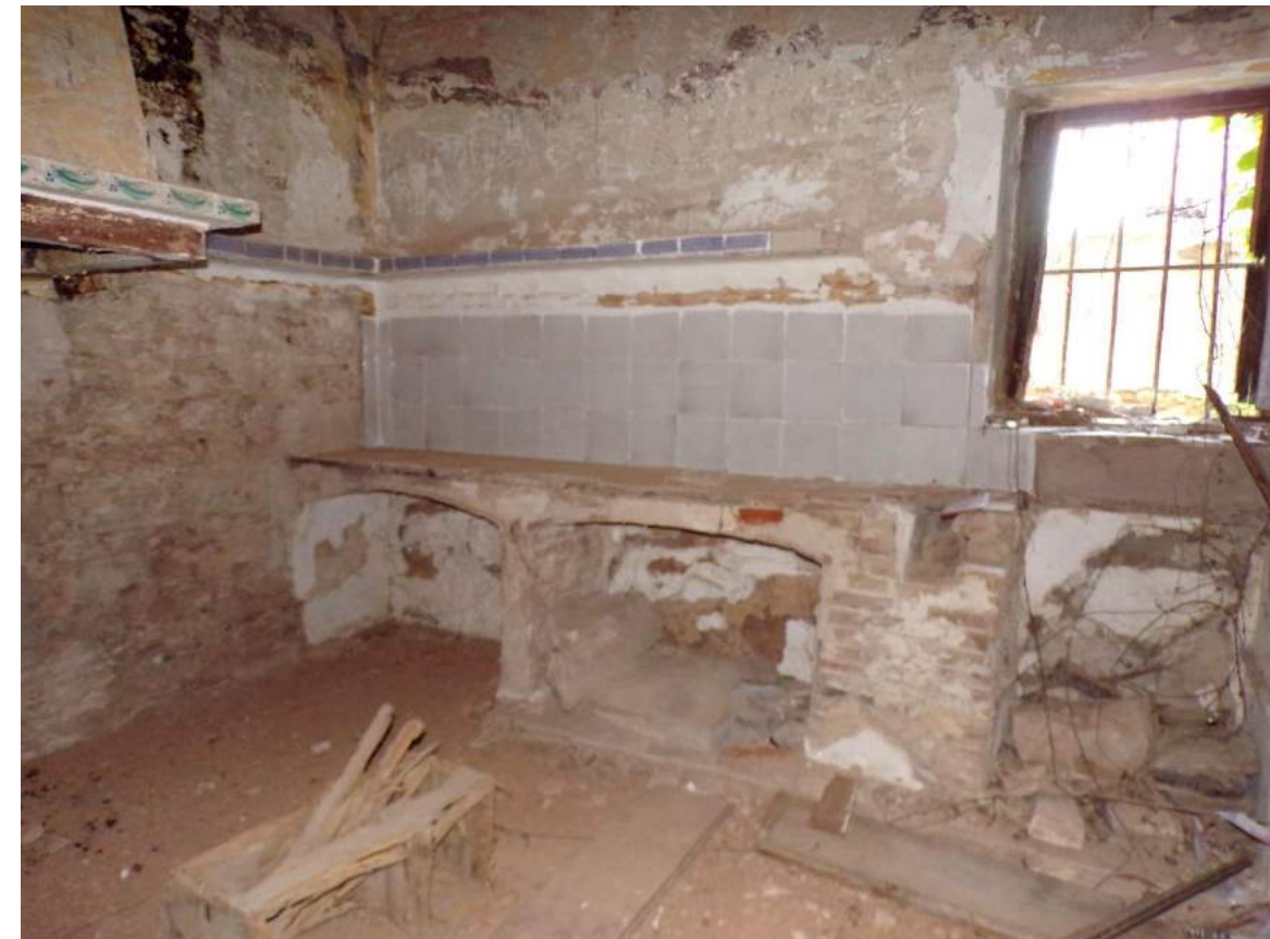
Ilustración 42. Estado actual de la cocina, situada en la nave C de la planta baja, 2016. Fuente: Propio autor
