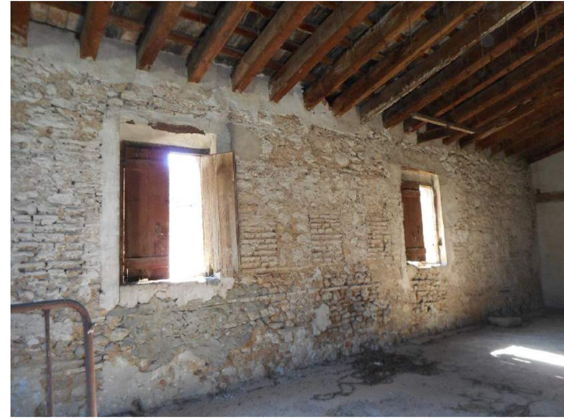
Ilustración 33. Disposición de las almenas en la estancia 2AA, 2016. Fuente: Propio Autor
