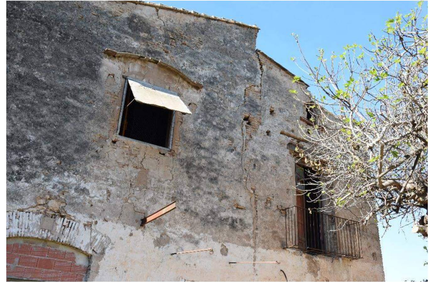
Ilustración 51. Ventana fachada norte, 2016. Fuente: Propio autor
