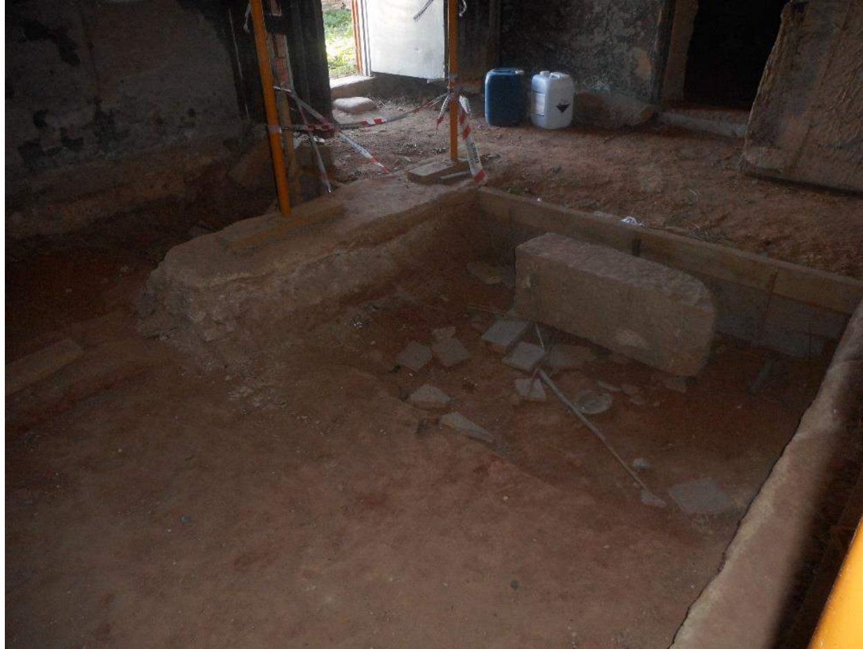
Ilustración 32. Vista de la cimentación como resultado de la excavación arqueológica en mayo de 2005, 2016. Fuente: Autor Propio
