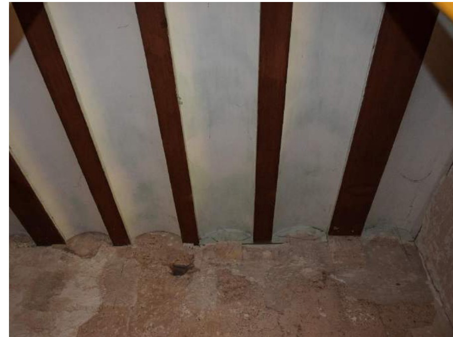
Ilustración 465. Encuentro vigas de madera con el muro, 2016. Fuente: Ana María Montero Mondría
