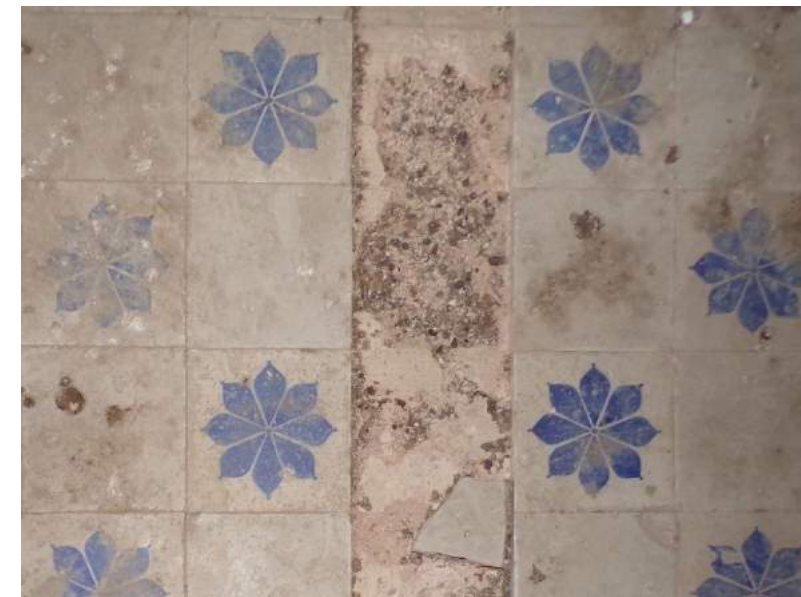
Ilustración 55. Pavimento cerámico de producción industrial en la nave 2C, 2016. Fuente: Propio autor
