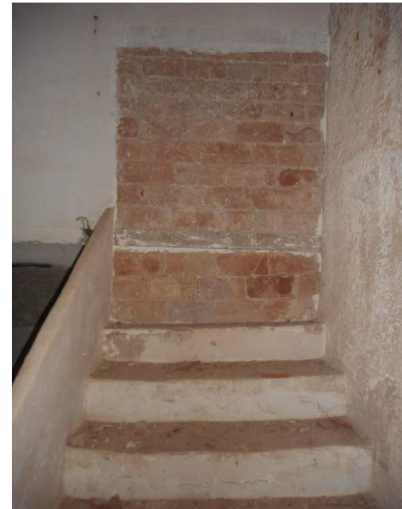
Ilustración 38. Salida de escalera tapiada, 2016. Fuente: Propio autor
