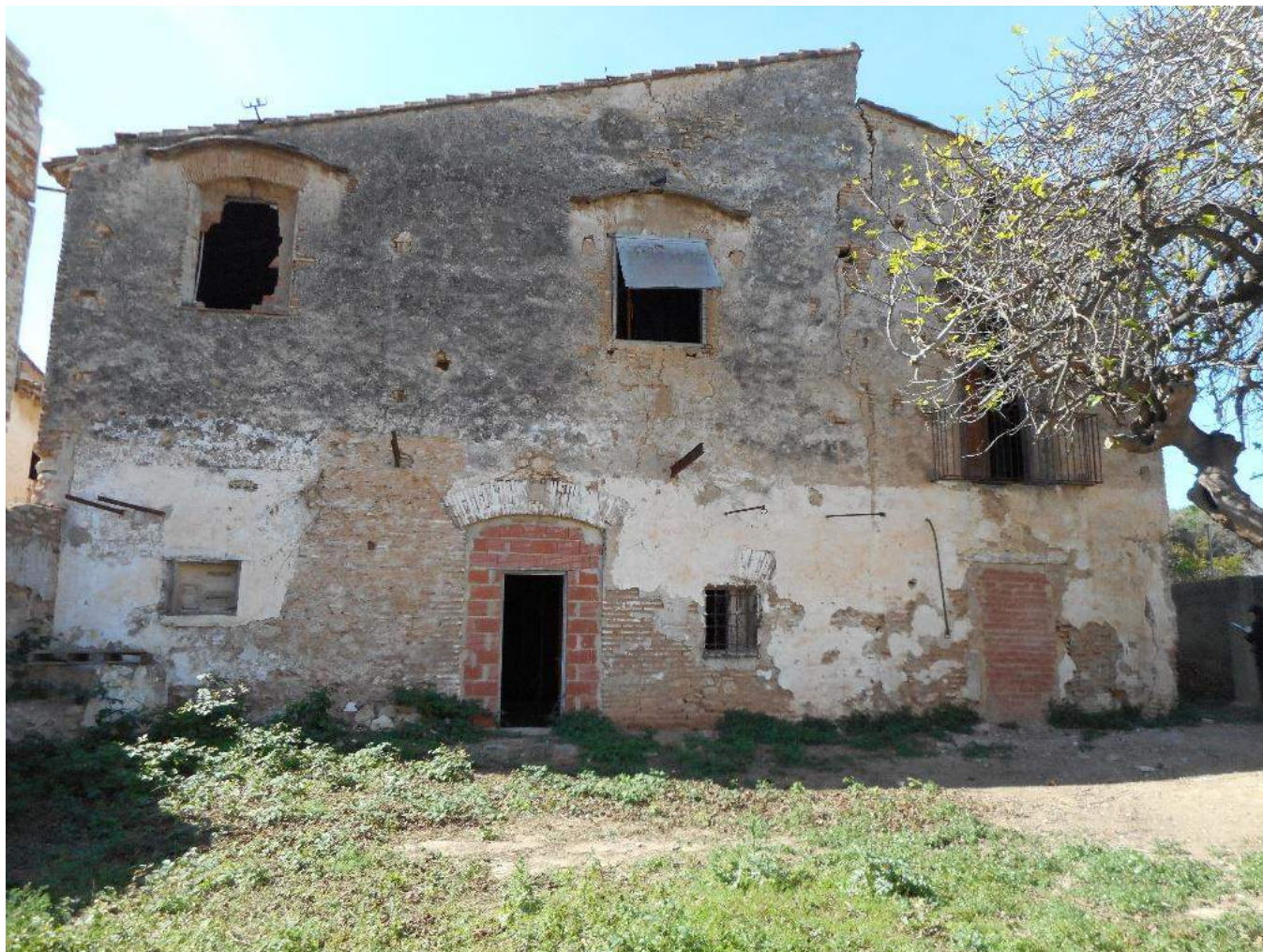
Ilustración 1. Fachada norte de la Alquería del Moro, 2016. Fuente: Propio Autor.
