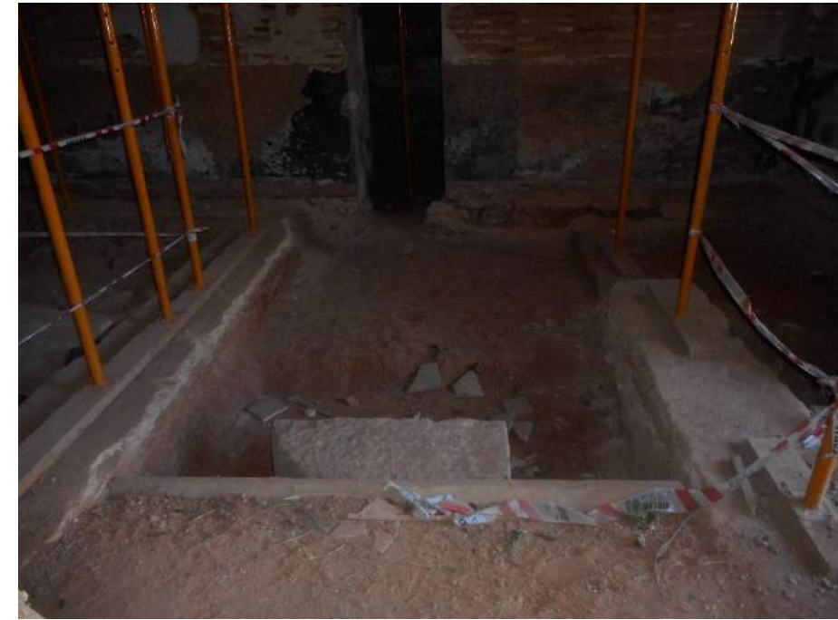
Ilustración 37. Excavación de la cimentación, 2016. Fuente: Propio autor
