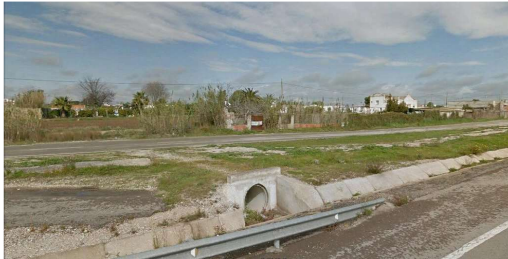
Figura 3.7. Margen izquierda de la carretera, cuarto tramo.
