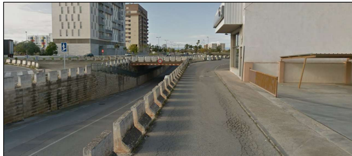
Figura 3.37 – Espacios peatonales muy deficientes en este enlace urbano degradado. Fuente: elaboración propia.
