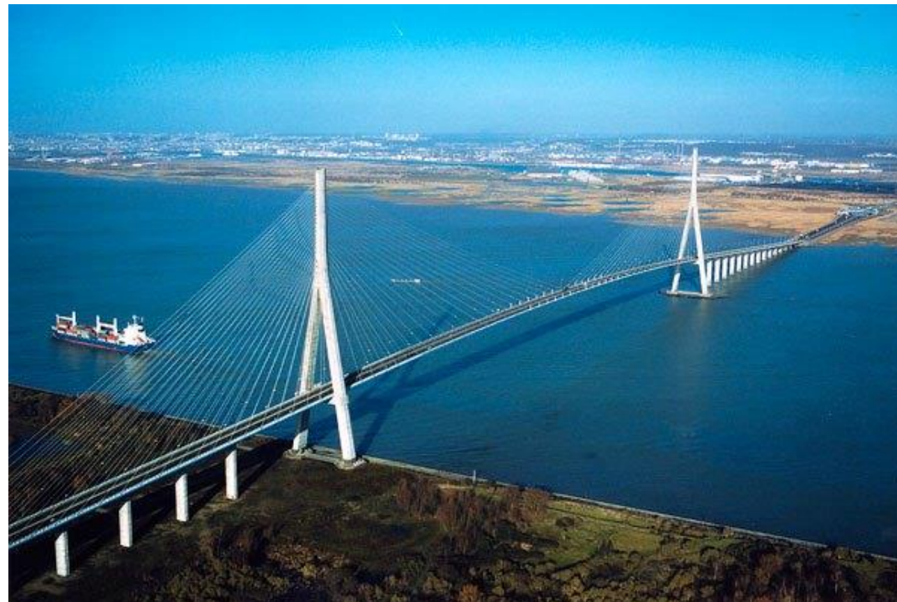
Figura 7. Alzado puente atirantado
