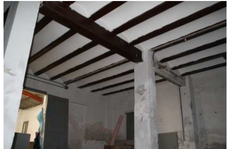
Figura 28. Forjado de revoltón de ladrillos. Autor propio
