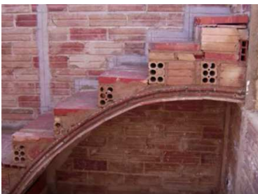
Figura 32. Boveda tabicada. Replanteo y construcción escalera bóveda a la catalana vídeo nº1. YouTube
