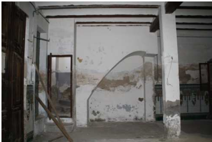
Figura 31. Escalera de bóveda tabicada. Autor propio
