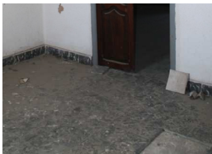
Figura 36. Pavimento hidráulico. Planta Primera. Autor propio
