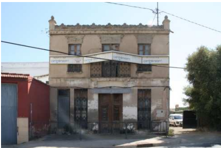
Figura 12. Rectificación fachada principal de la Alquería. Autor propio
