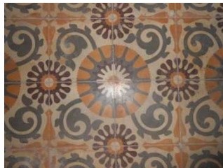
Figura 35. Pavimento hidráulico. Planta baja. Autor propio
