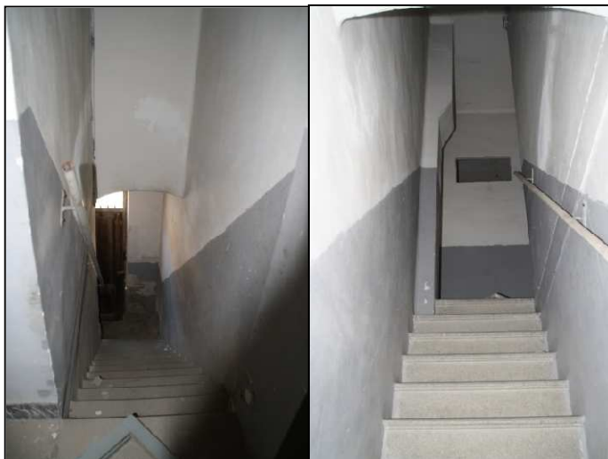
Figura 23. Escalera Alquería. Autor propio
