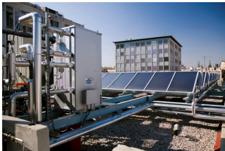
Figura 3.2 Máquina de refrigeración por absorción. [2]
