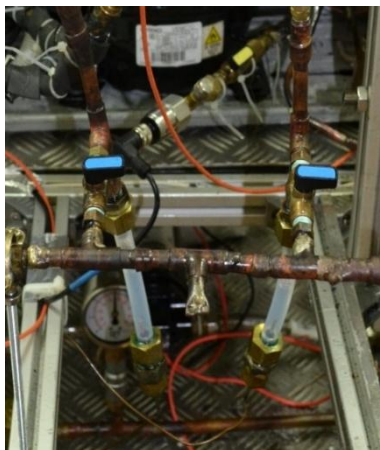
Figura 5.1 Filtros y tubos capilares.
