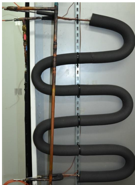
Figura 5.6 Protección térmica y colocación en la instalación.
