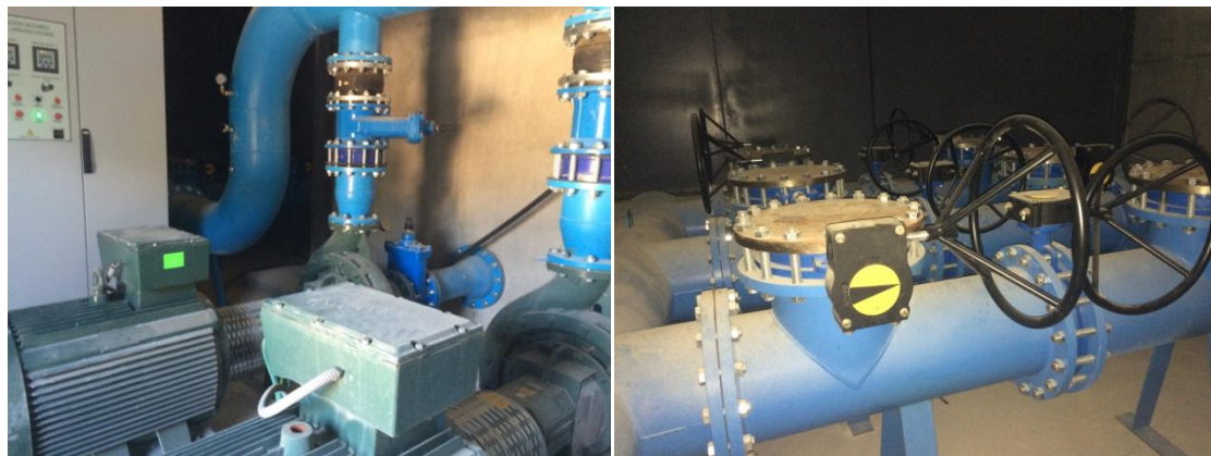
Fig. 24 Instalación de filtrado de agua. Fuente propia
