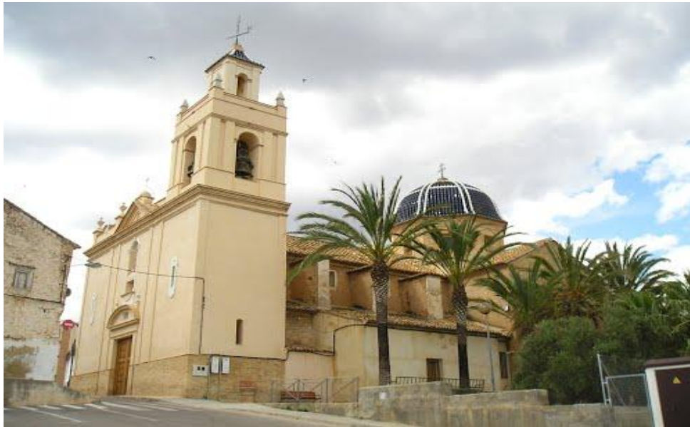
Fig. 5 Iglesia de San Pedro Apóstol.
