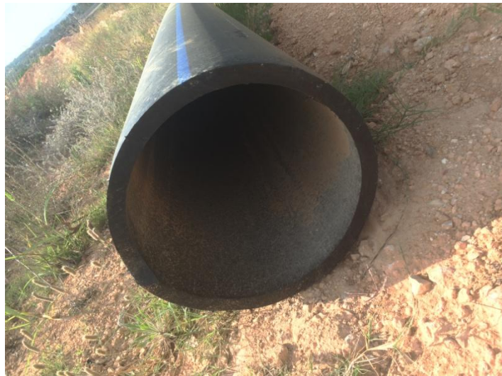
Fig. 57 Tubería de polietileno para las conducciones subterráneas de agua. Fuente propia.
