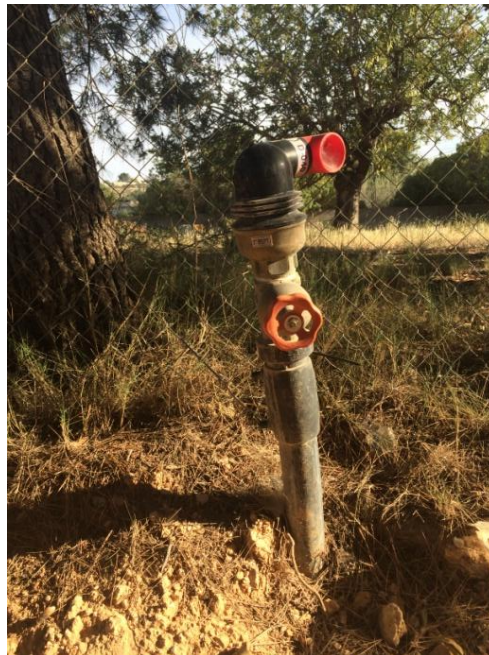
Fig. 59 Válvula de desahogo de presión. Fuente propia.
