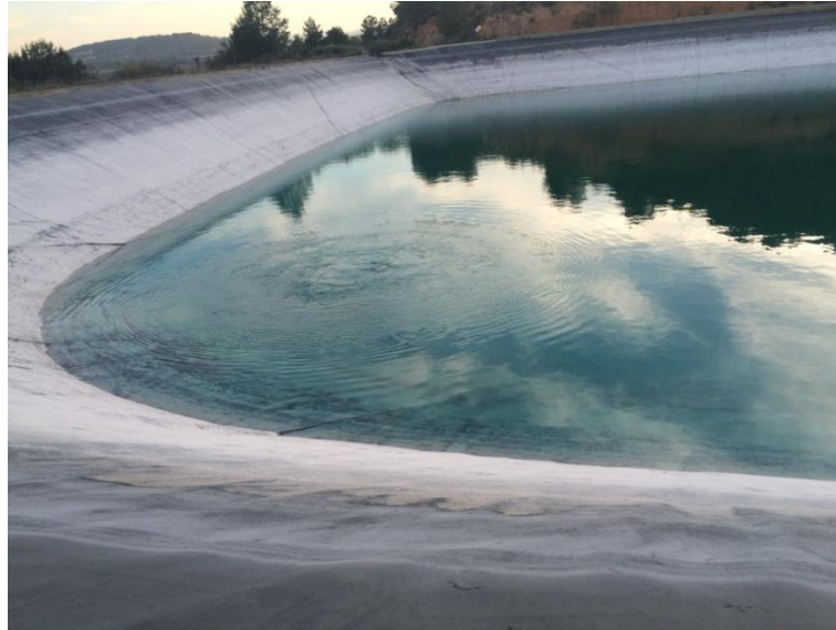
Fig. 27 Balsa del Ferrajón. Fuente propia
