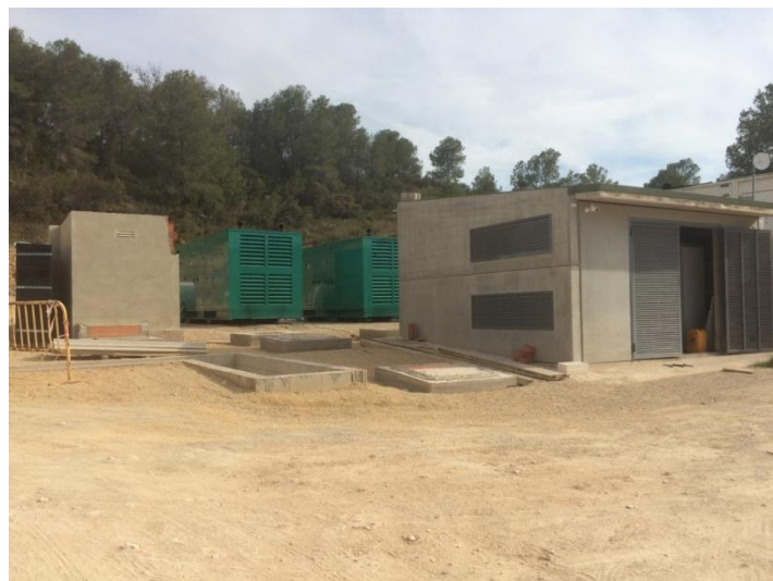
Fig. 16 Obra instalación pozos. Fuente propia
