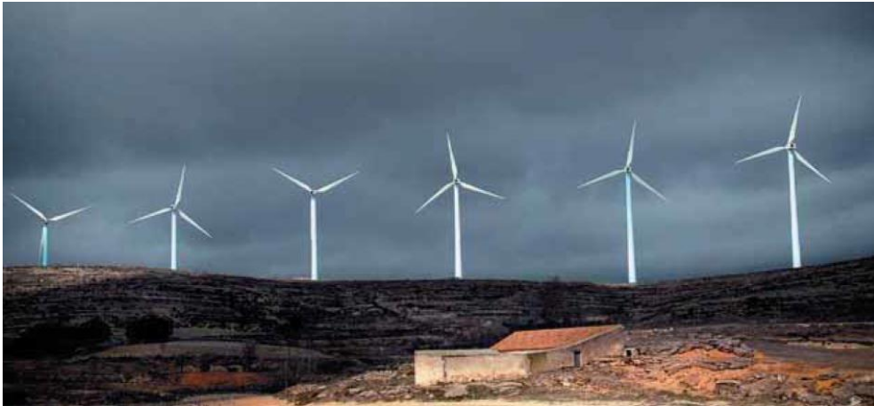
Figura. 1. Ejemplo de un parque eólico on shore.
