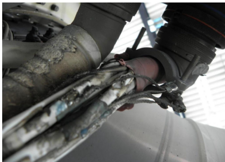
Figura A.8: Cables de transmisión
