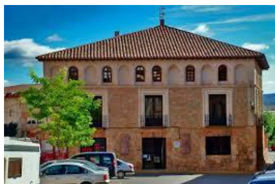
Ilustración 17 - Fachada del edificio
