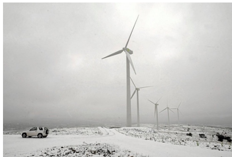
Figura 4. Vista del Parque Eólico “Mazorral y Rajola” (Alto del Mazorral) (Fuente: Diario El Mundo, consultado el 13/5/16)
