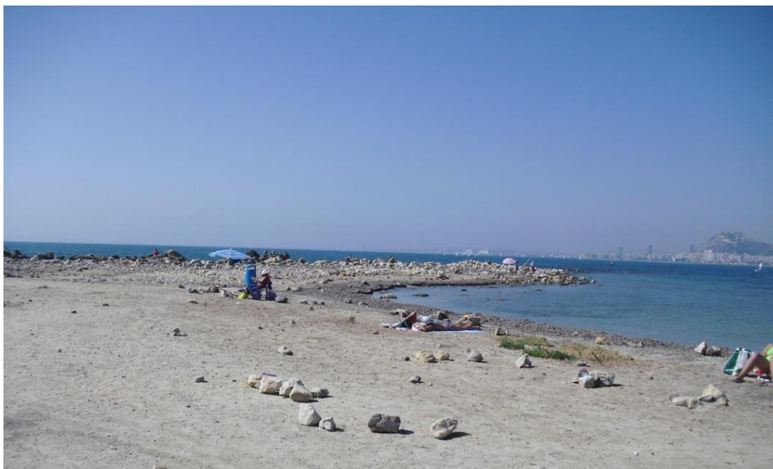
Imagen 3: Dique de abrigo.
