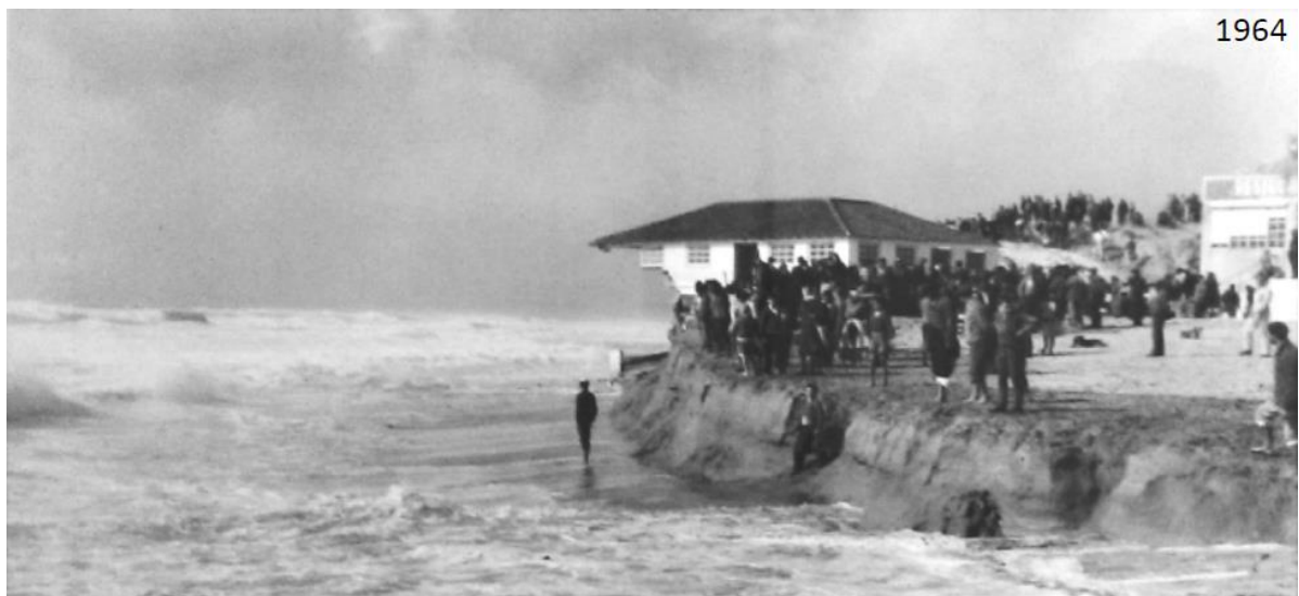
Figura 1.3: Daños provocados por temporales en la costa de Caparica (1964). Fuente: Aleixo Pinto 2015
