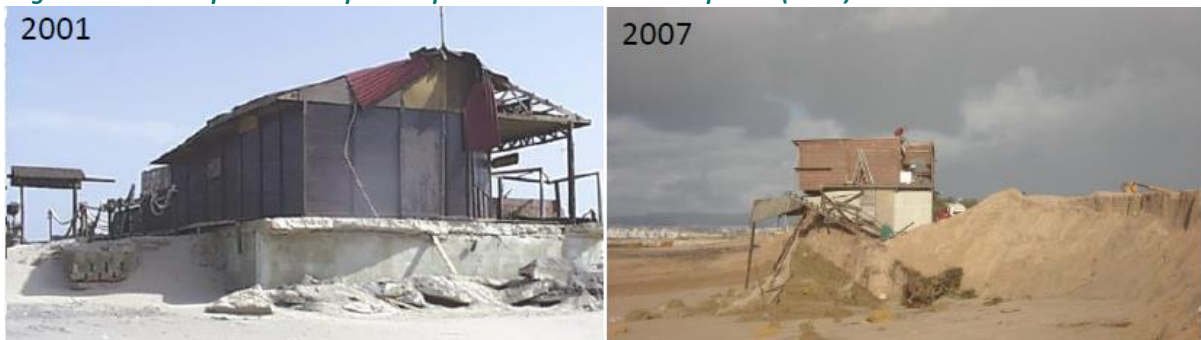
Figuras 1.4: Daños provocados por temporales en la costa de Caparica (2001 y 2007). Fuente: Aleixo Pinto 2015
