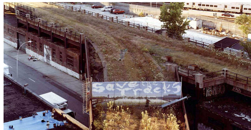
Fig. 27. The High Line antes de su transformación. Cartel de la asociación Friends of the High Line para evitar su demolición.
