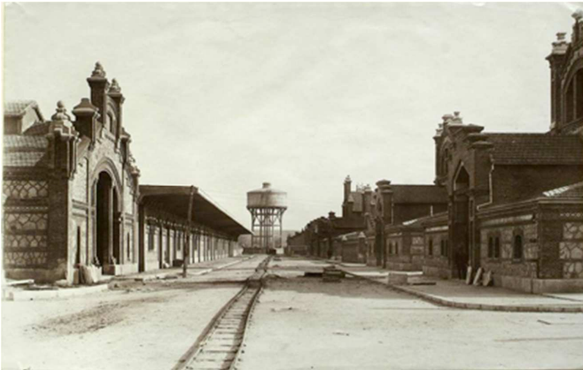
Fig. 52. Naves de degüello, garaje y depósito de agua.
