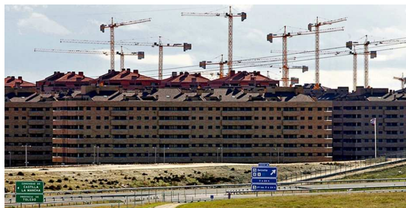
Fig. 16. Construcción de 5.092 pisos en Seseña.
