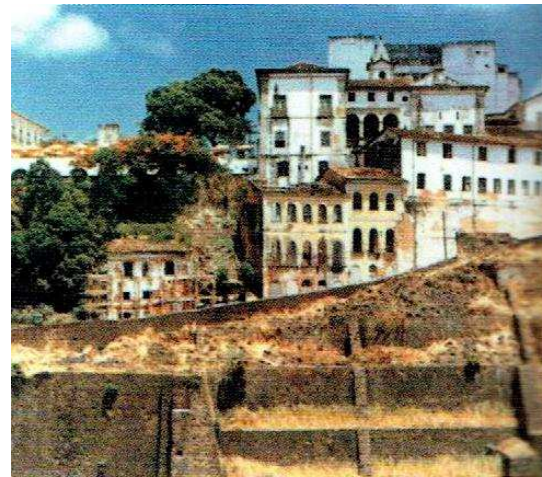
Fig. 34. Vista del estado previo a la intervención, 1986. Marcelo Carvalho Ferraz
