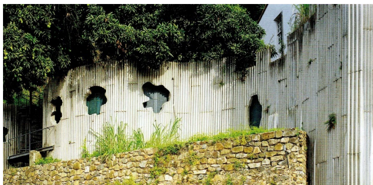
Fig. 37. Restaurante Coatí. Fachada de paneles modulares.
