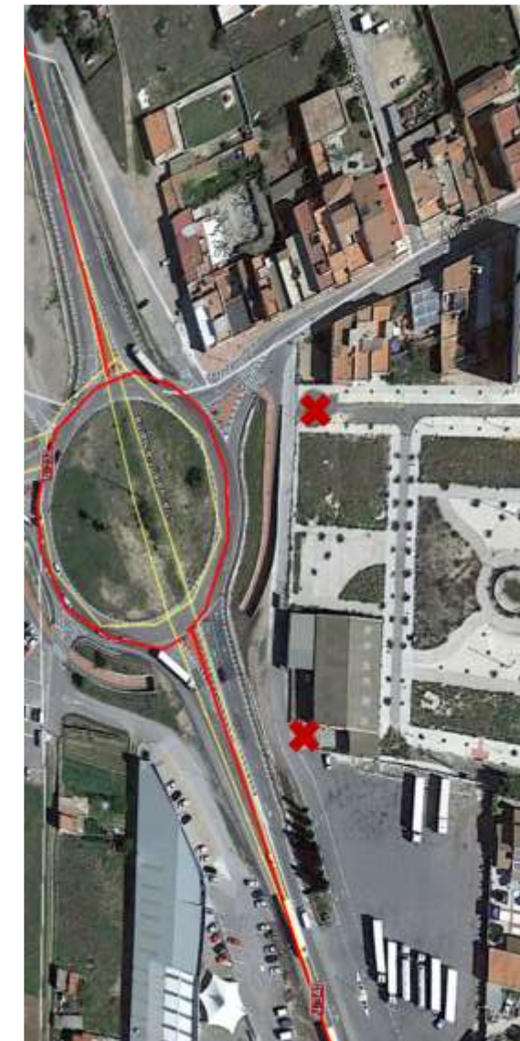
Figura 3.18. Problemática existente en las uniones planeadas y no ejecutadas 5 y 6, marcadas con una cruz Fuente: Elaboración propia con el soporte Google Earth 2015
