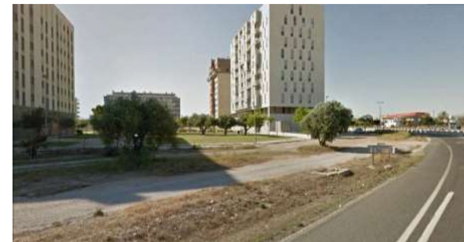
Figura 3.6. Margen izquierda de la carretera, tercer tramo
