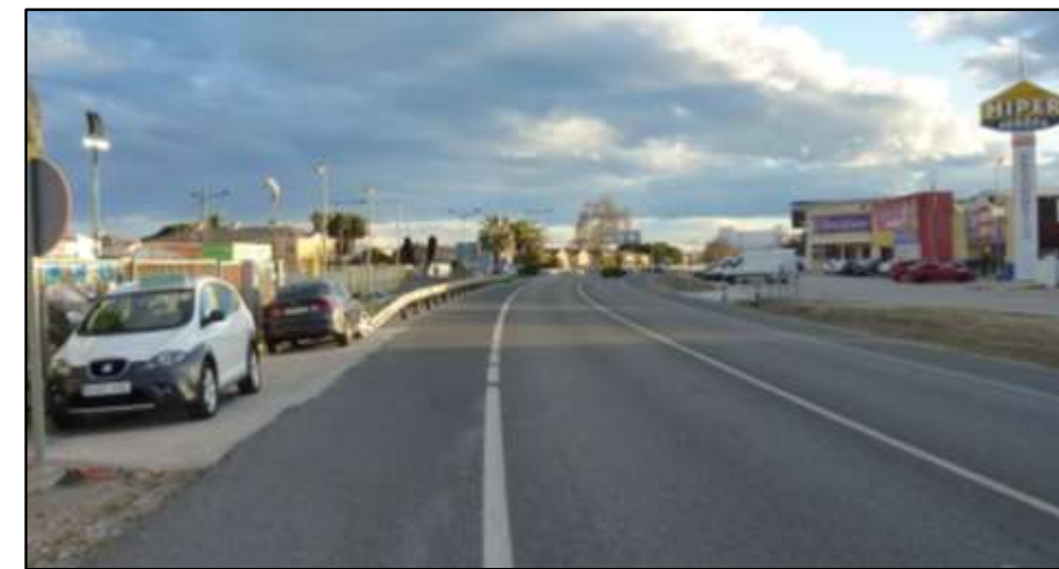
Figura 3.35 – Vehículos estacionados en la propia plataforma de la carretera. Fuente: elaboración propia.
