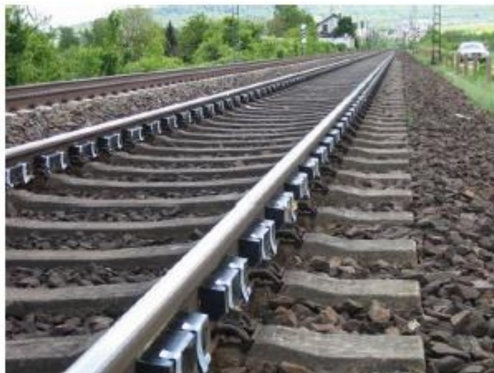
Figura 4.17. Material de amortiguamiento en el alma del carril. Fuente: [76]
