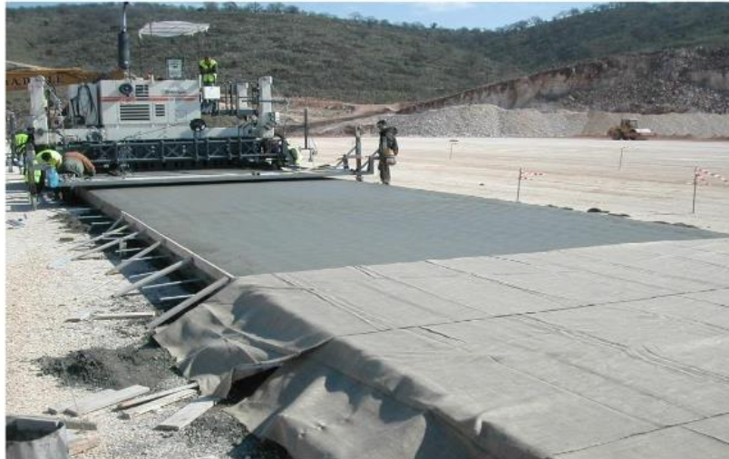
Figura 3.7. Pavimento de puerto realizado con hormigón reforzado con fibras. Fuente: [38]
