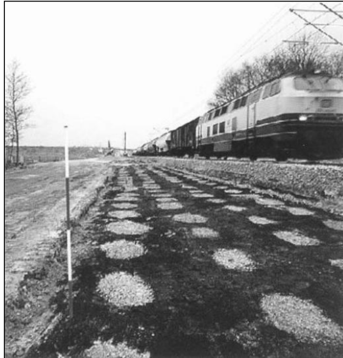
Figura 4.12. Mejora de las propiedades del terreno sobre el que se emplaza la vía mediante columnas de grava. Fuente: [74]
