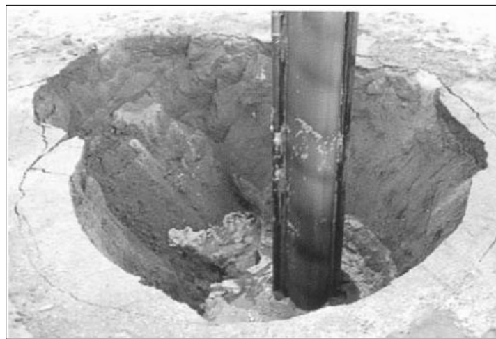
Figura 4.15. Proceso de vibrocompactado de un suelo no cohesivo. Fuente: [75]
