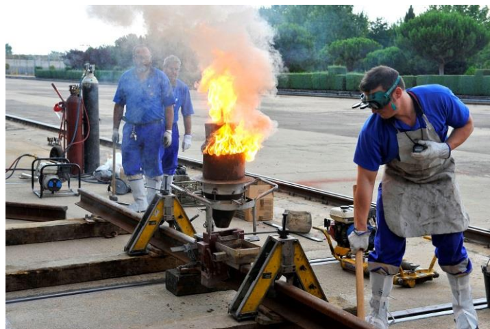
Figura 5.7. Ejemplo de soldadura aluminotérmica. Fuente: [83]
