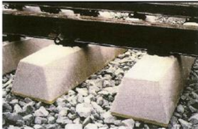
Figura 4.3. Suela elástica bajo traviesa. Fuente: [9]
