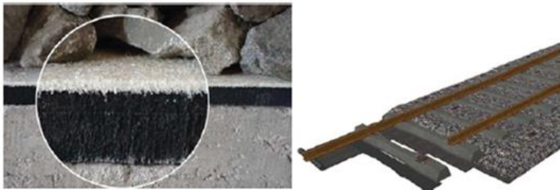
Figura 4.6. Manta elástica bajo capa de balasto. Fuente: [62]
