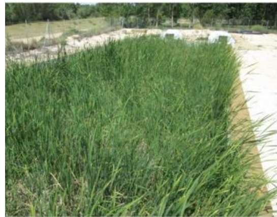
Figura 11 Depuradora combinada de macrofitas y biodiscos
