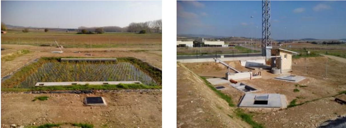
Figura 8 Depuradora de macrofitas en Lantarón
