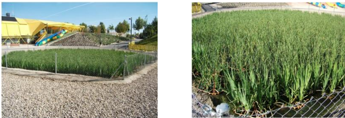
Figura 13 Depuradora de macrofitas en Parque Rivas-Ecópolis
