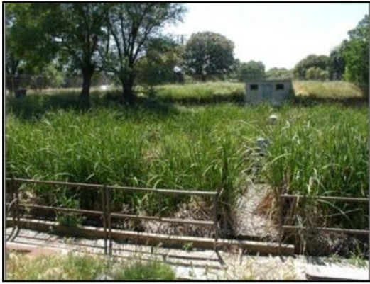
Figura 9 Depuradora de macrofitas combinada con convencional infradimensionada
