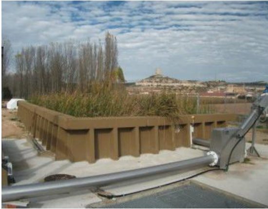
Figura 11 Depuradora combinada de macrofitas y biodiscos
