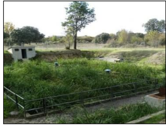
Figura 9 Depuradora de macrofitas combinada con convencional infradimensionada
