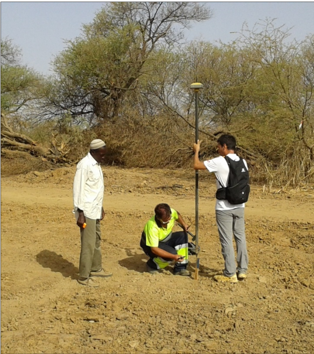
referencias altimétricas sobre estacas.
