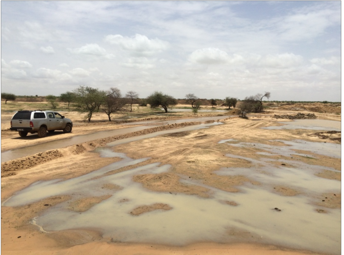
obra en época de lluvias.
