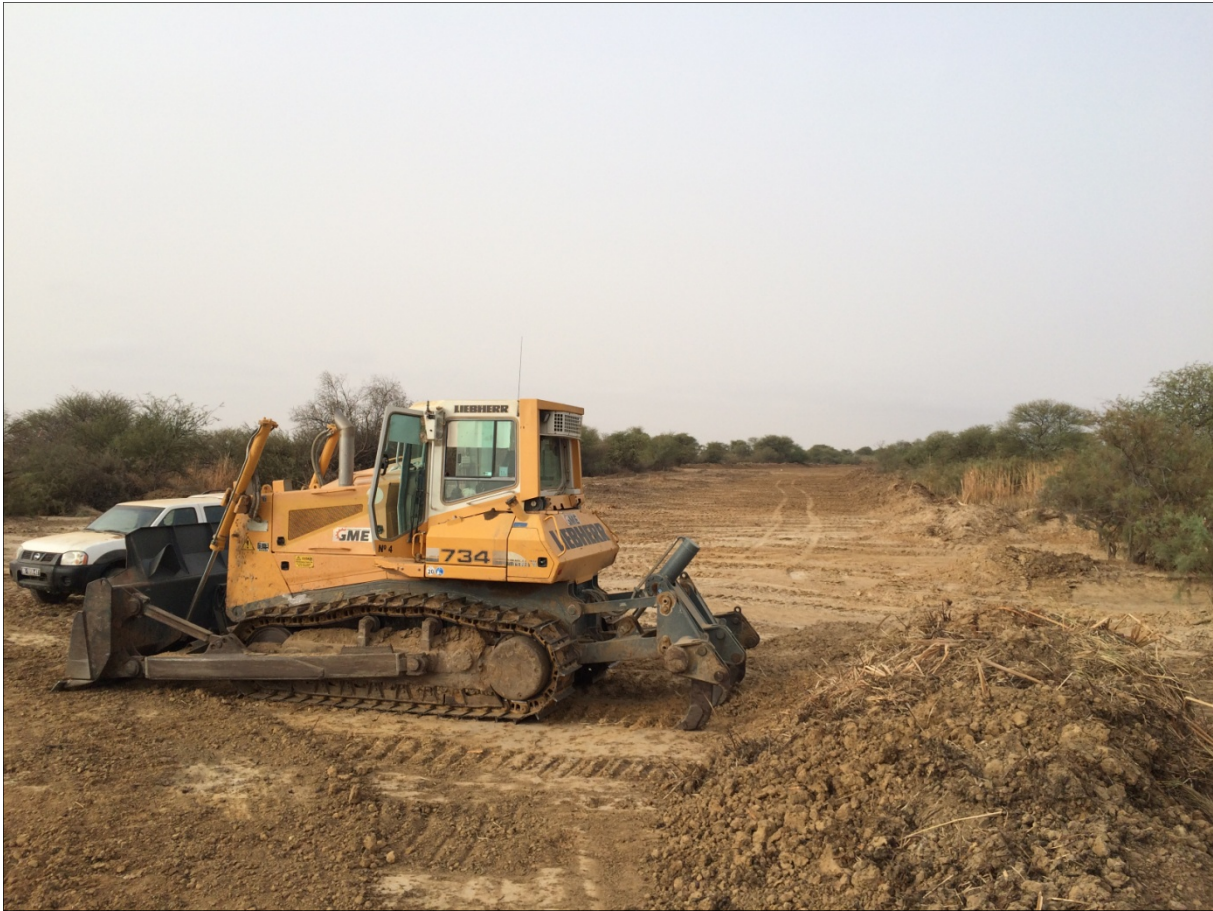
explanación de parcelas con bulldozer
