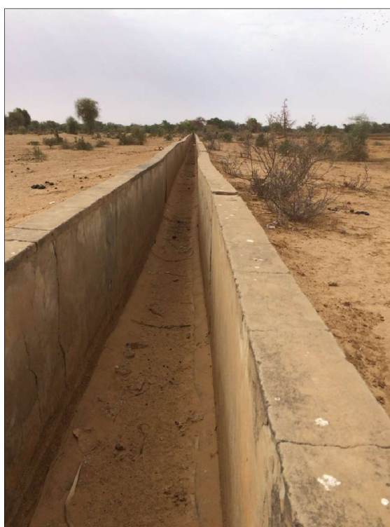
canales de obra actuales a restaurar.
