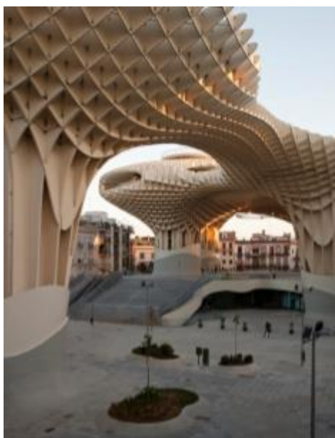
1.3. Madera estructural en nueva construcción.
