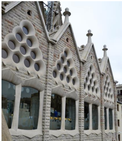
Fig. 93: Claustre perimetral de la SF.
