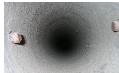
Fig. 103: Interior de la campana.
