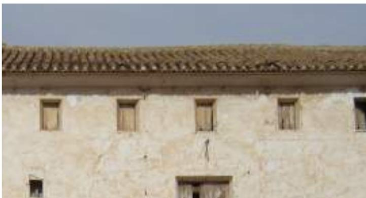
El alero en la alquería Falcó es un alero con moldura (liso, sin ornamentación y con una pendiente de 45°) rematado con un vuelo simple de rasilla.
