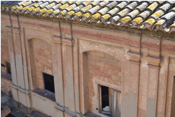
Figura 48. Arcos escarzanos del nivel superior (Alejandro Serra 2016).
