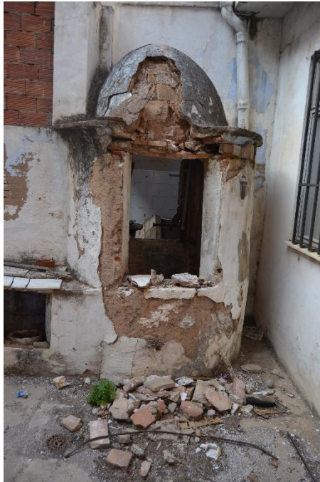
Figura 43. Estado actual del pozo original (Alejandro Serra 2016).
