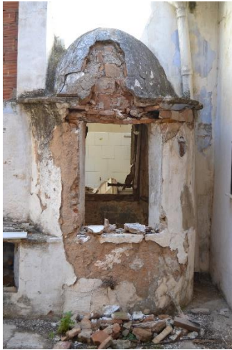
Figura 49. Estado actual del pozo original (Alejandro Serra 2016).
