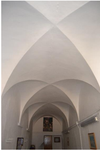
Figura 55. Boveda de arista original del convento (Alejandro Serra 2016).
