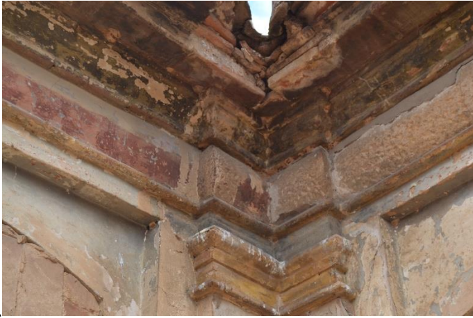
Figura 53. Cornisa original del convento de Beniparrell. (Alejandro Serra 2016).
