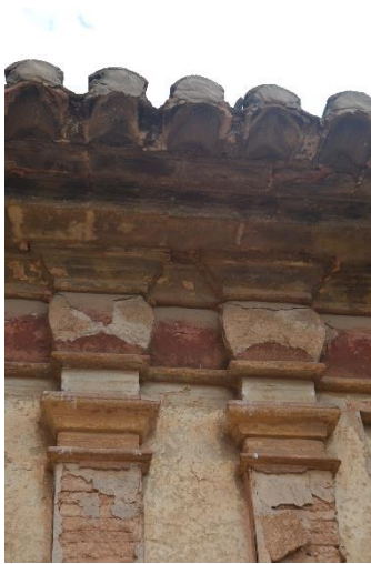
Figura 54. Cornisa original del convento de Beniparrell. (Alejandro Serra 2016).
