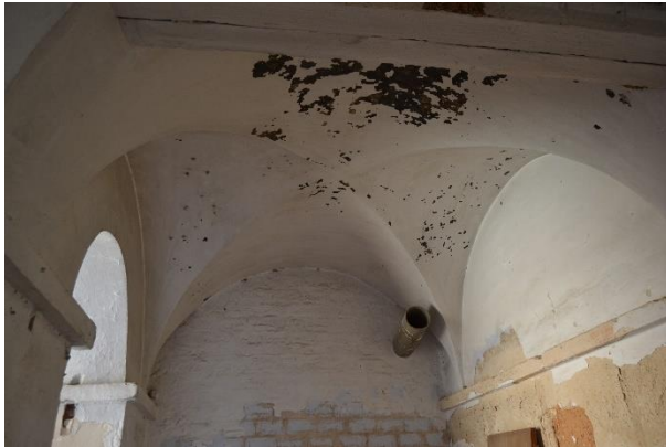
Figura 32. Bóveda de arista (Alejandro Serra 2016).
