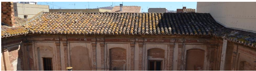
Figura 34. Cubierta de teja curva (Alejandro Serra 2016)
