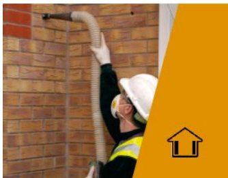
Figura 35. Espuma de lana mineral insuflada. 2016. Isover.
