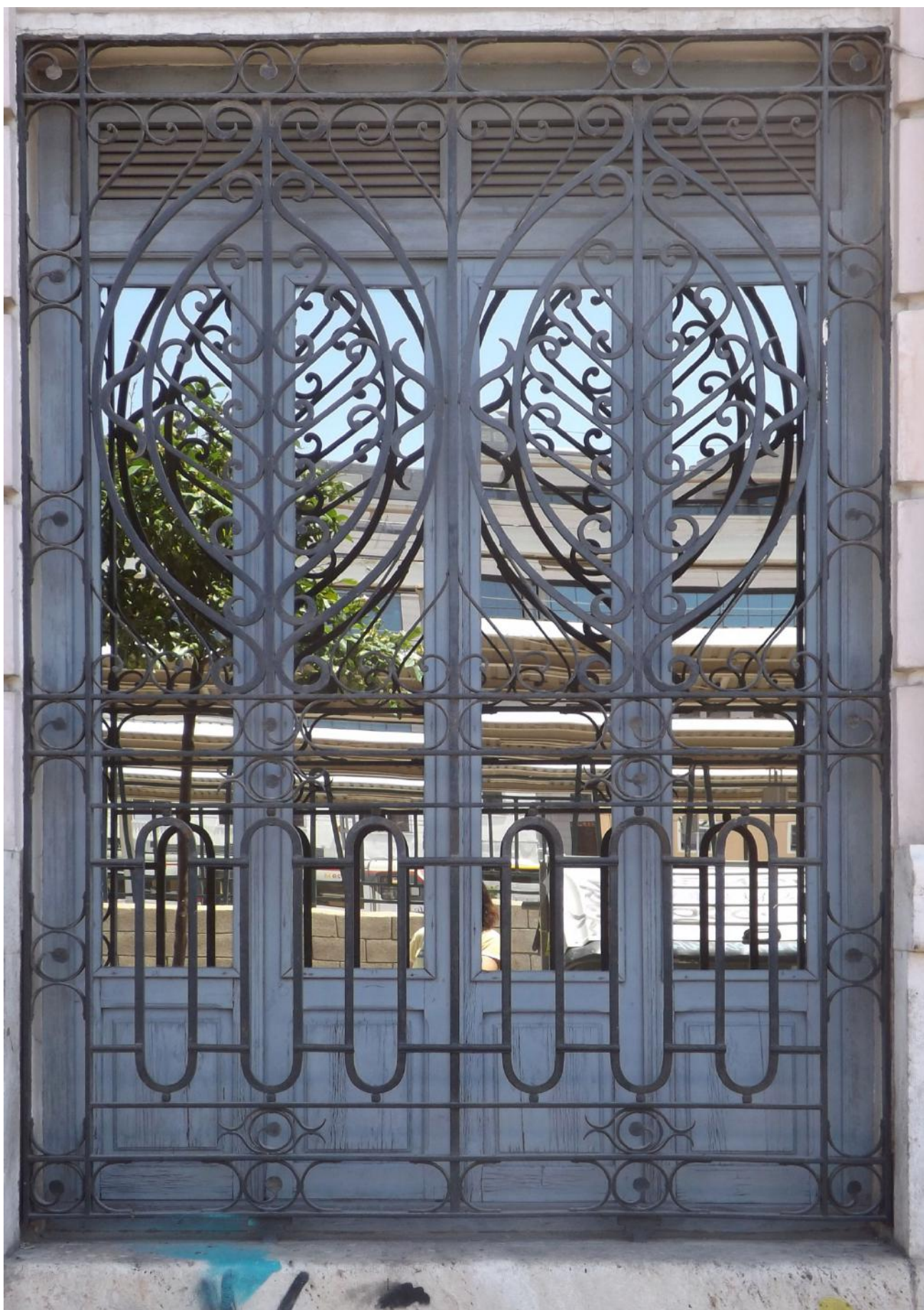
Lámina 94: C/ Alicante, 27 (46004, Valencia). Fuente: propia. 2016.
