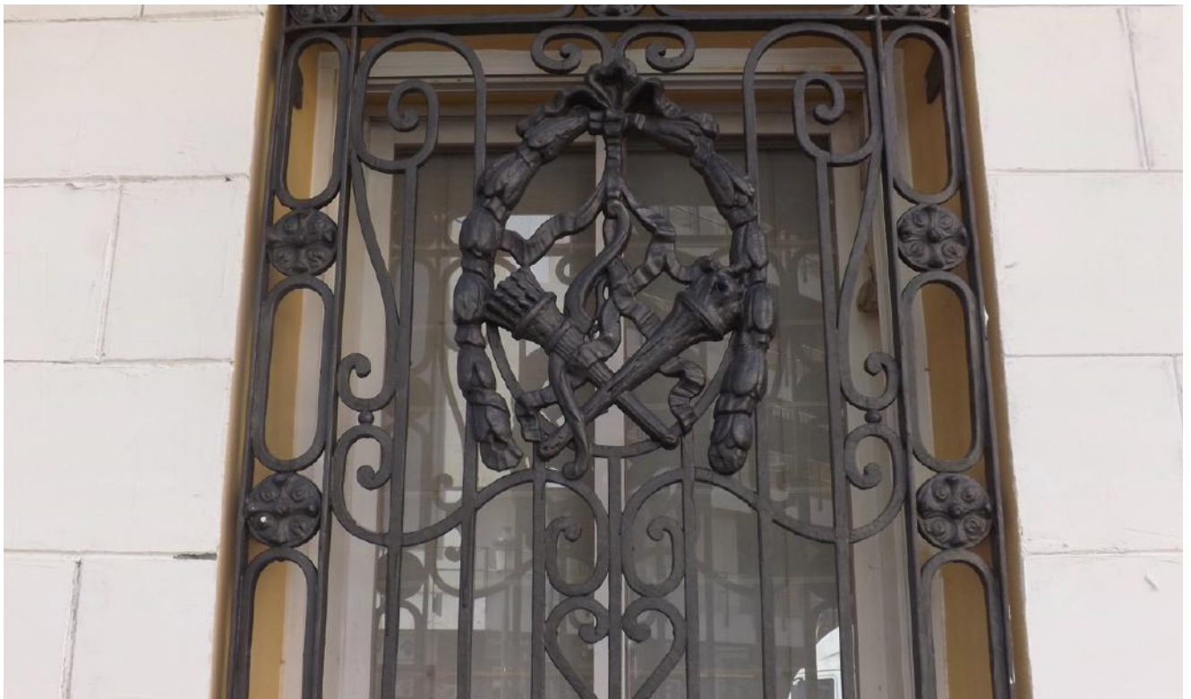
Lámina 19: Reja de ventana de Planta Baja de la calle Matías Perelló Nº9, en la que se puede observar que se repite el diseño de algunos elementos del grabado de la lámina anterior. Fuente: propia. 2016.
