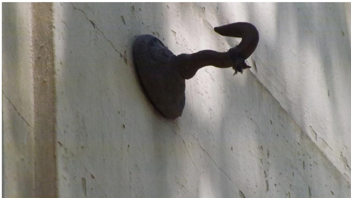
Lámina 107: Gran Vía de las Germanías, 22 (46004, Valencia). Fuente: propia. 2016.
