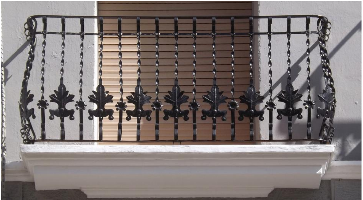
Lámina 48: C/ Matías Perelló,30 (46005, Valencia). Fuente: propia.2016.
