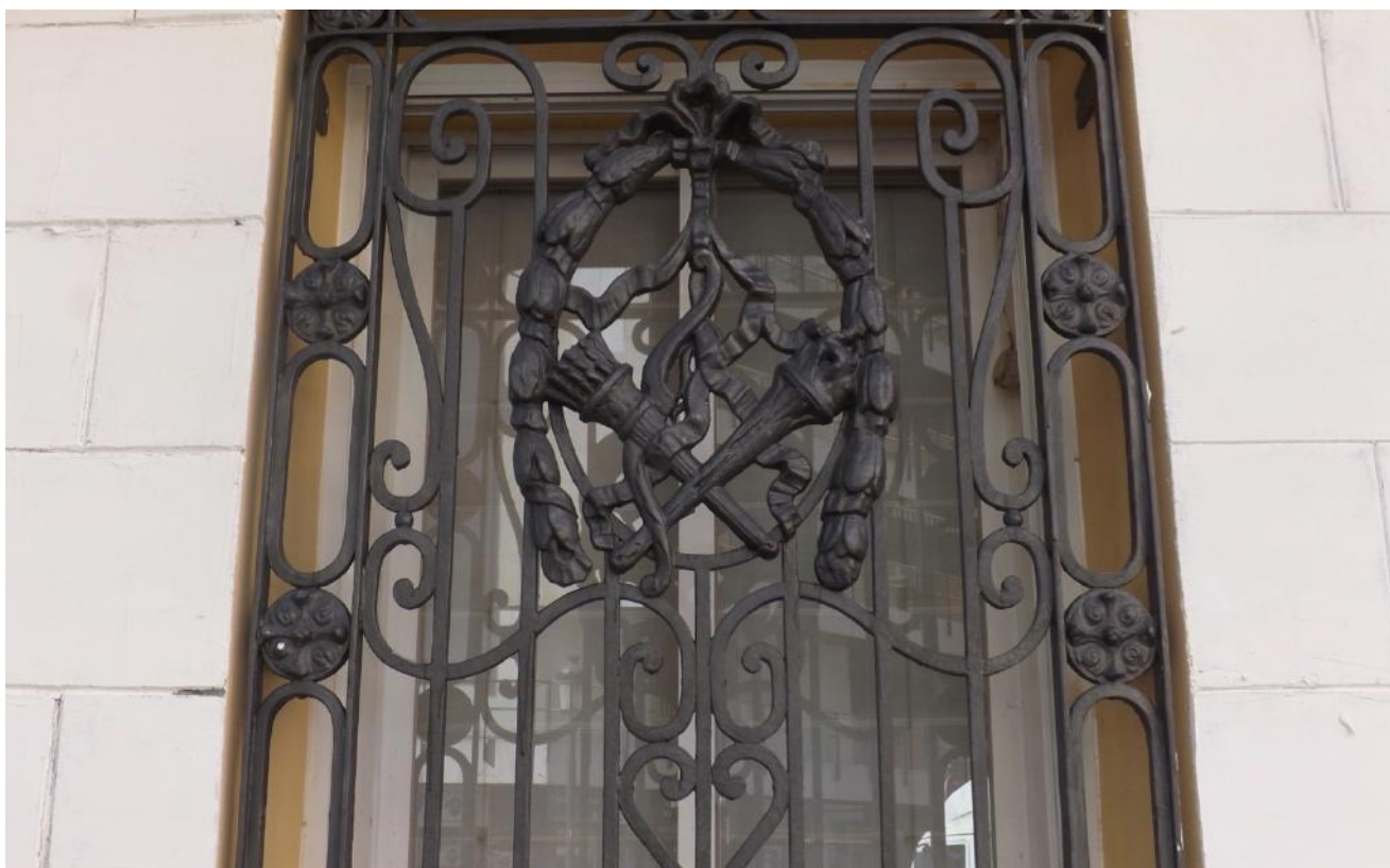
Lámina 75: C/ Matías Perelló , 9 (46006, Valencia). Fuente: propia.2016.
