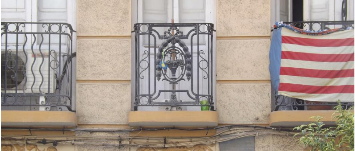
Lámina 71: C/ Sueca , 43 (46006, Valencia). Fuente: propia.2016.
