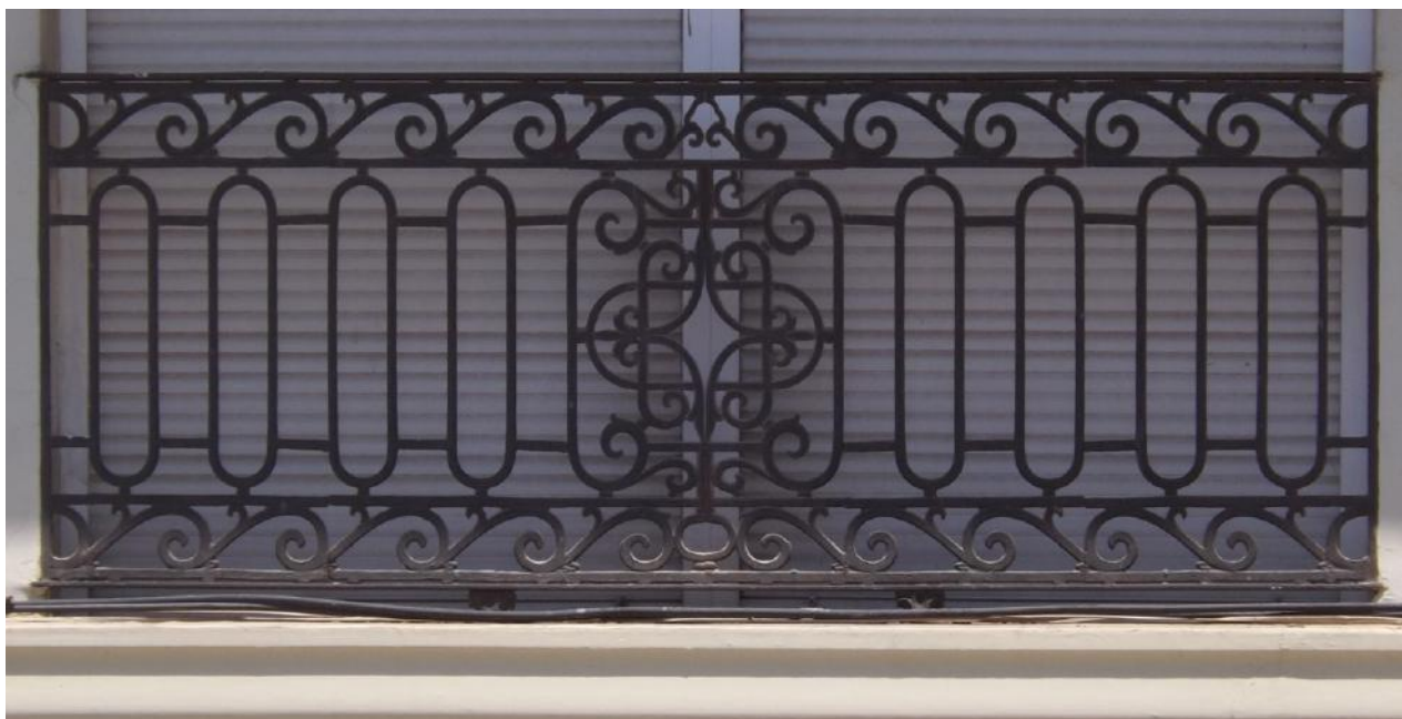
Lámina 38: C/ Alicante, 19 (46004, Valencia). Fuente: propia.2016.
