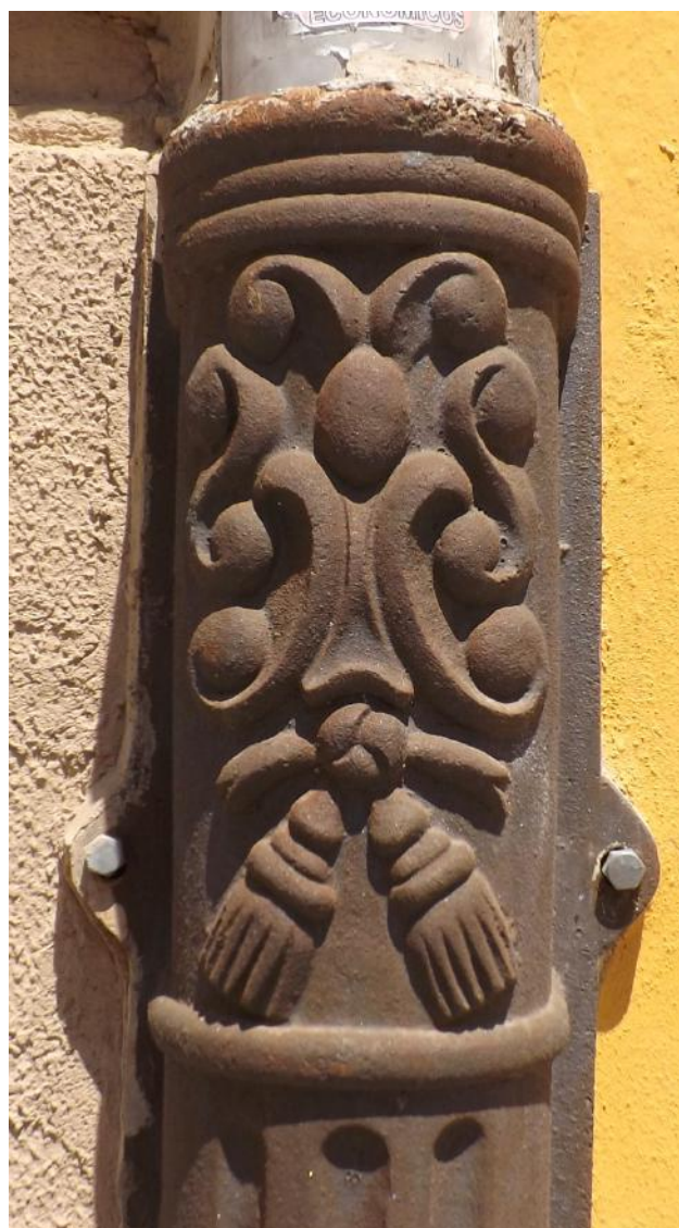
Lámina 128: Bajante en fachada. C/ Buenos Aires, 22 (46004, Valencia). Fuente: propia.2016.
