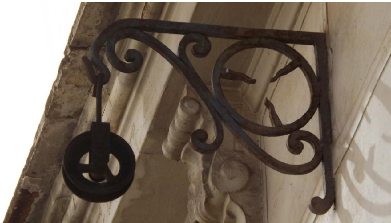
Lámina 100: C/ Matías Perelló, 31 (46005, Valencia). Fuente: propia. 2016.
