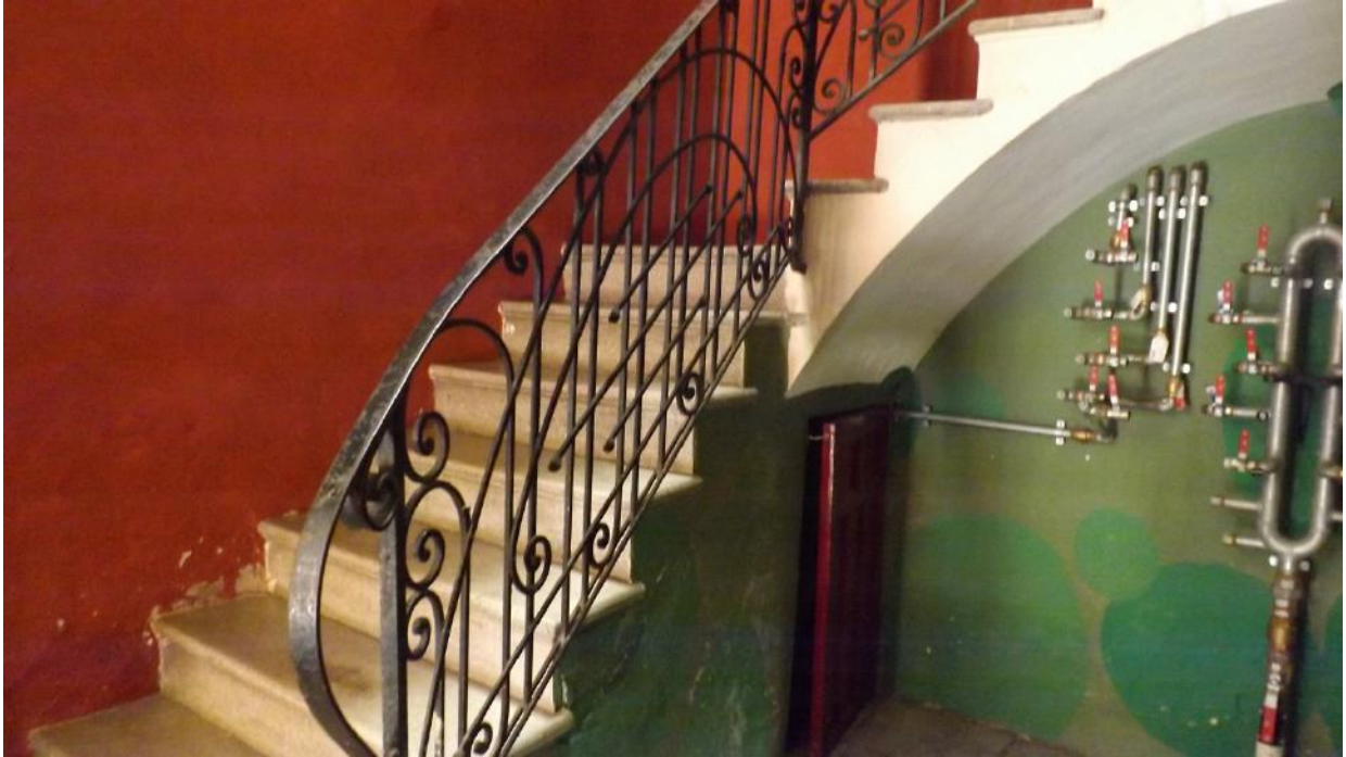
Lámina 77: Escalera de interior de edificio. C/ Sevilla, 2 (46006, Valencia). Fuente: propia. 2016.
