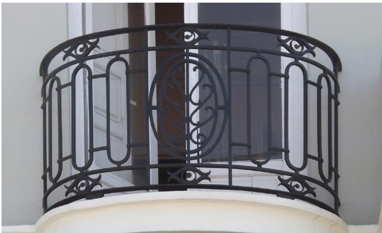
Lámina 43: C/ Alicante, 29 (46005, Valencia). Fuente: propia.2016.
