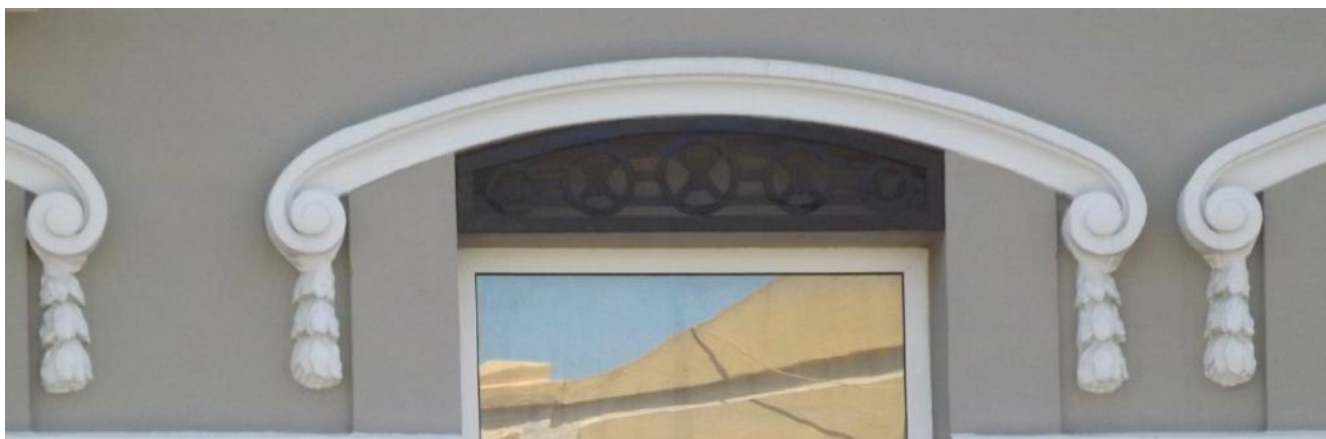
Lámina 86: Gran Vía de las Germanías, 34 (46004, Valencia). Fuente: propia. 2016.
