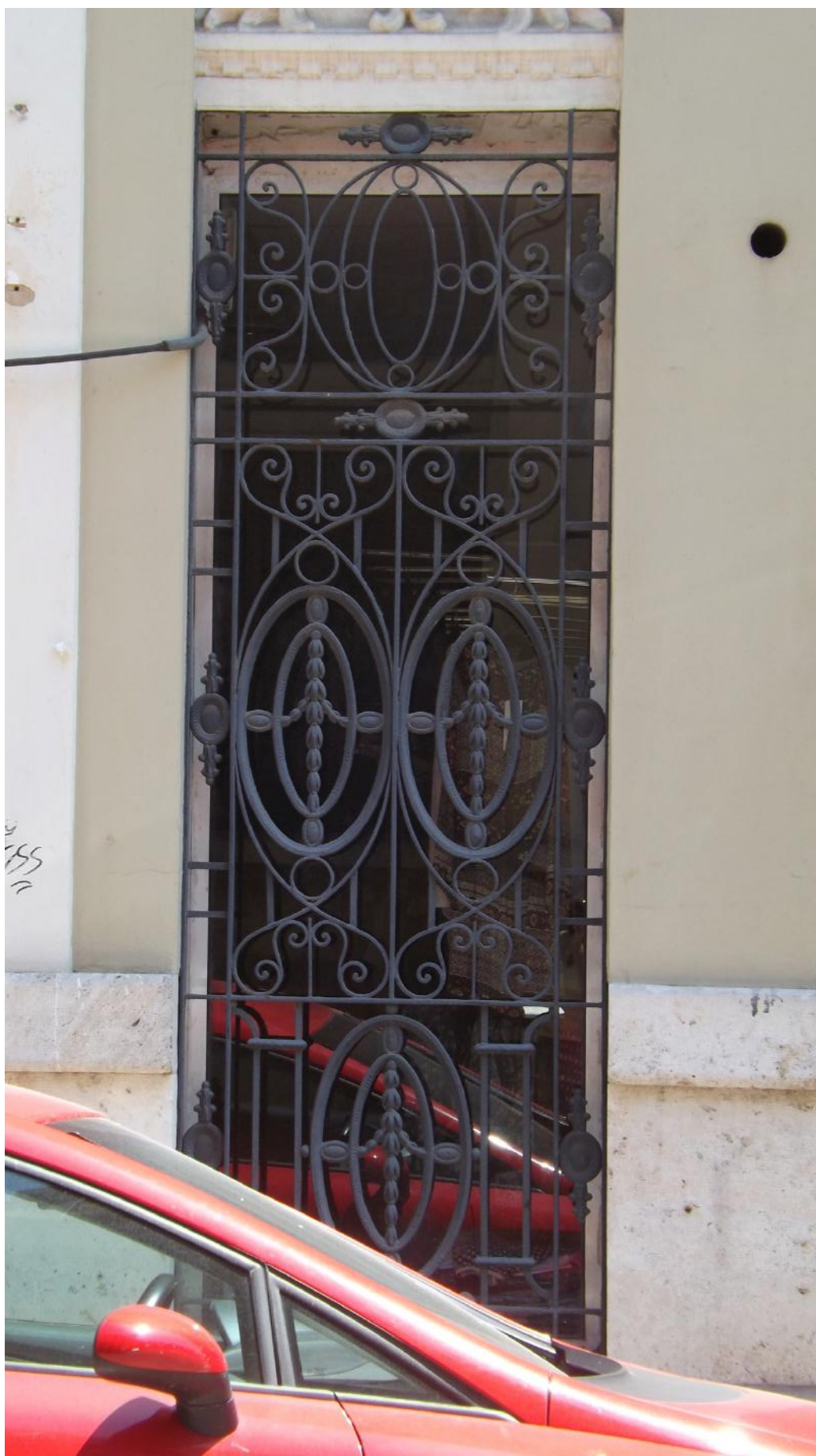
Lámina 95: C/ Alicante, 7 (46004, Valencia). Fuente: propia. 2016.
