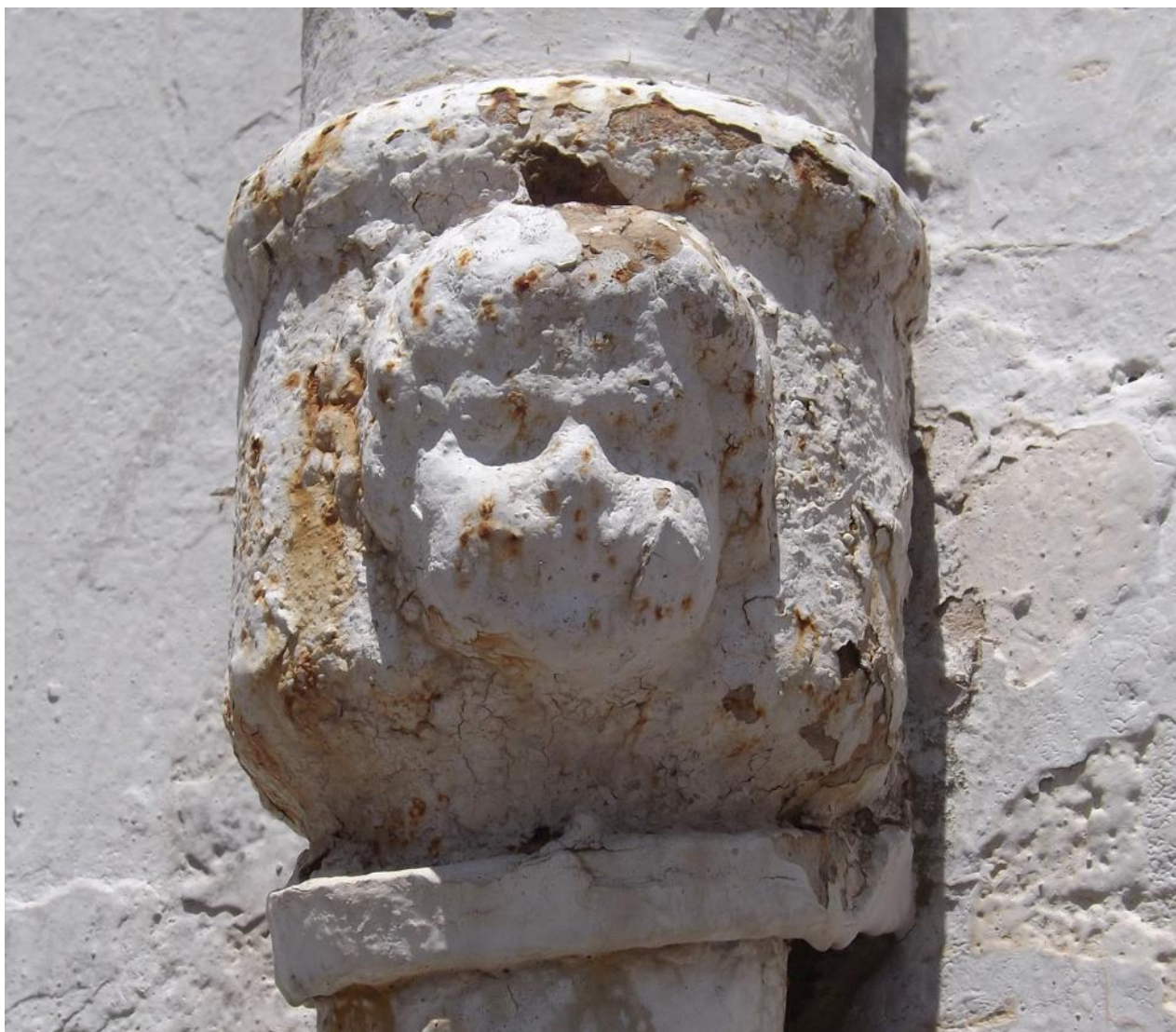
Lámina 126: Bajante en fachada. C/ Buenos Aires, 22 (46004, Valencia). Fuente: propia.2016.
