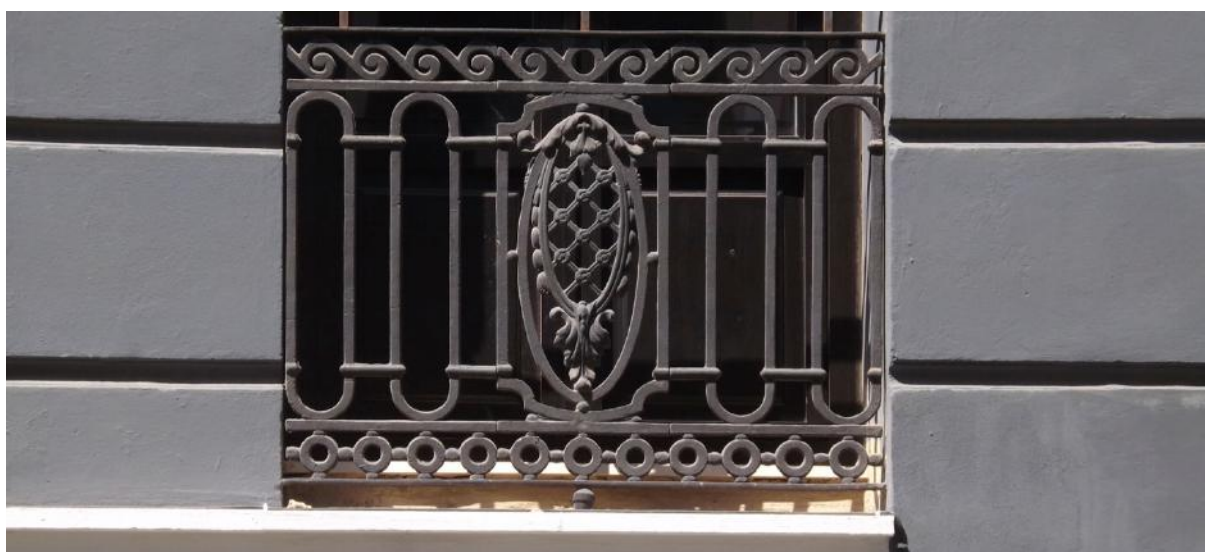
Lámina 65: C/ Sueca, 16 (46006, Valencia). Fuente: propia.2016.
