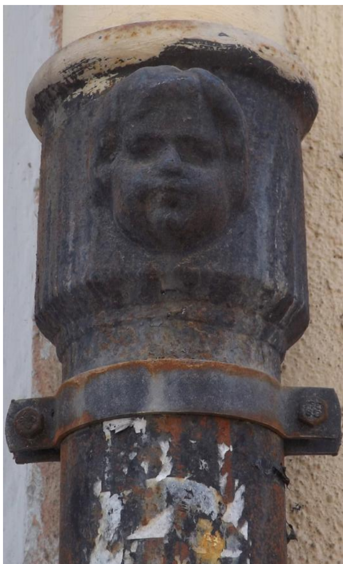
Lámina 127: Bajante en fachada. C/ Cádiz, 92 (46004, Valencia). Fuente: propia.2016.
