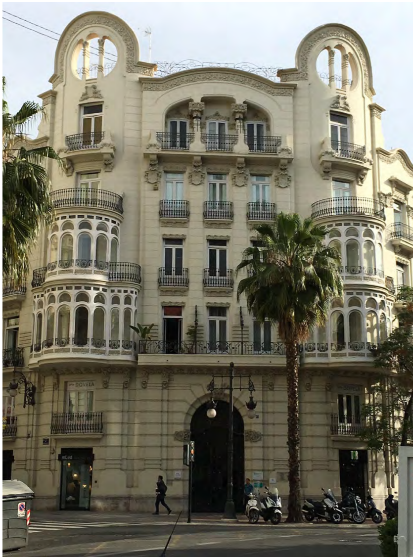
Imagen 79. Fachada principal Chaflán Gran Vía Marqués del Turia N°65
