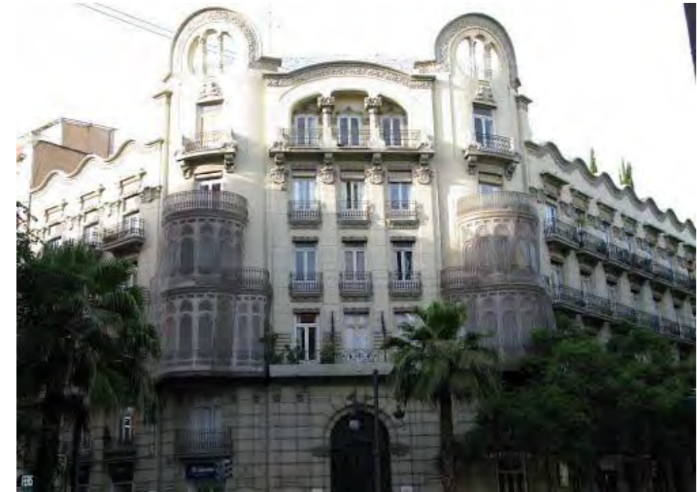
Imagen 28. Fachada Principal Edificio Chapa N°65, Valencia
