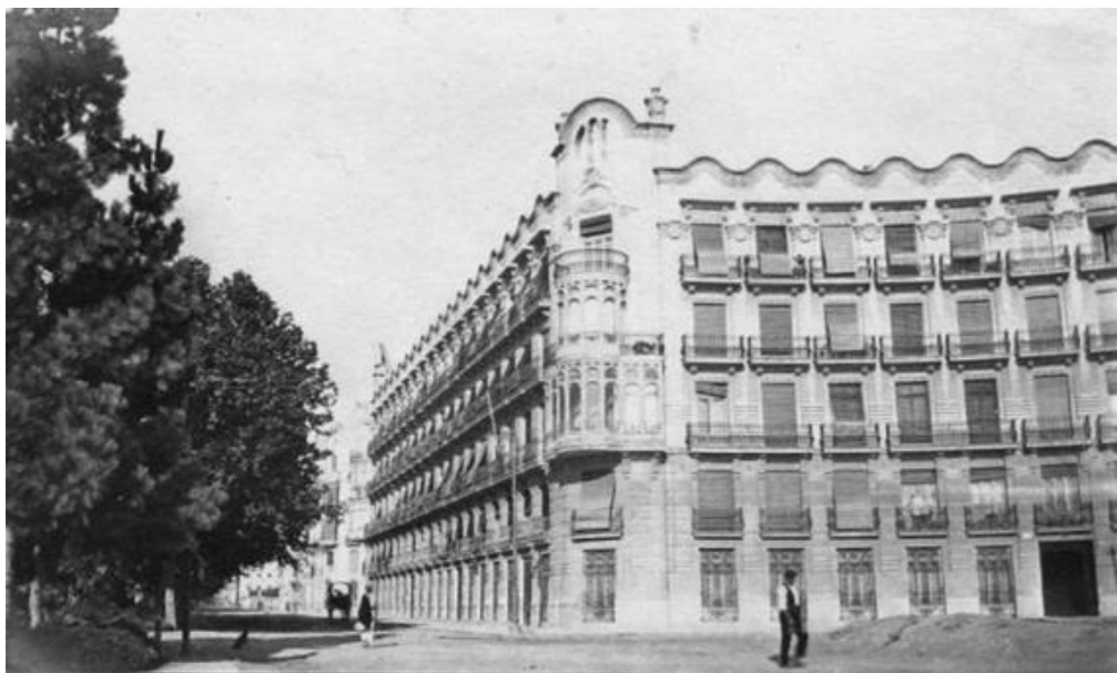
Imagen 49. Primer Tramo Edificio Chapa, Plaza Canovas-Gran Vía Marqués del Turia.
