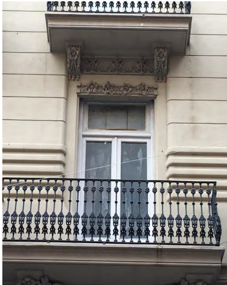
Imagen 94. Barandilla y elementos ornamentales de la fachada de la segunda planta inspirados en la tendencia modernista
