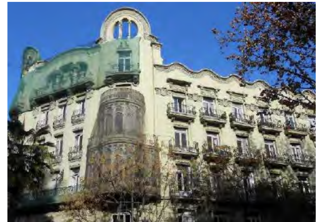
Imagen 29. Fachada Principal Edificio Chapa N°65, Valencia
