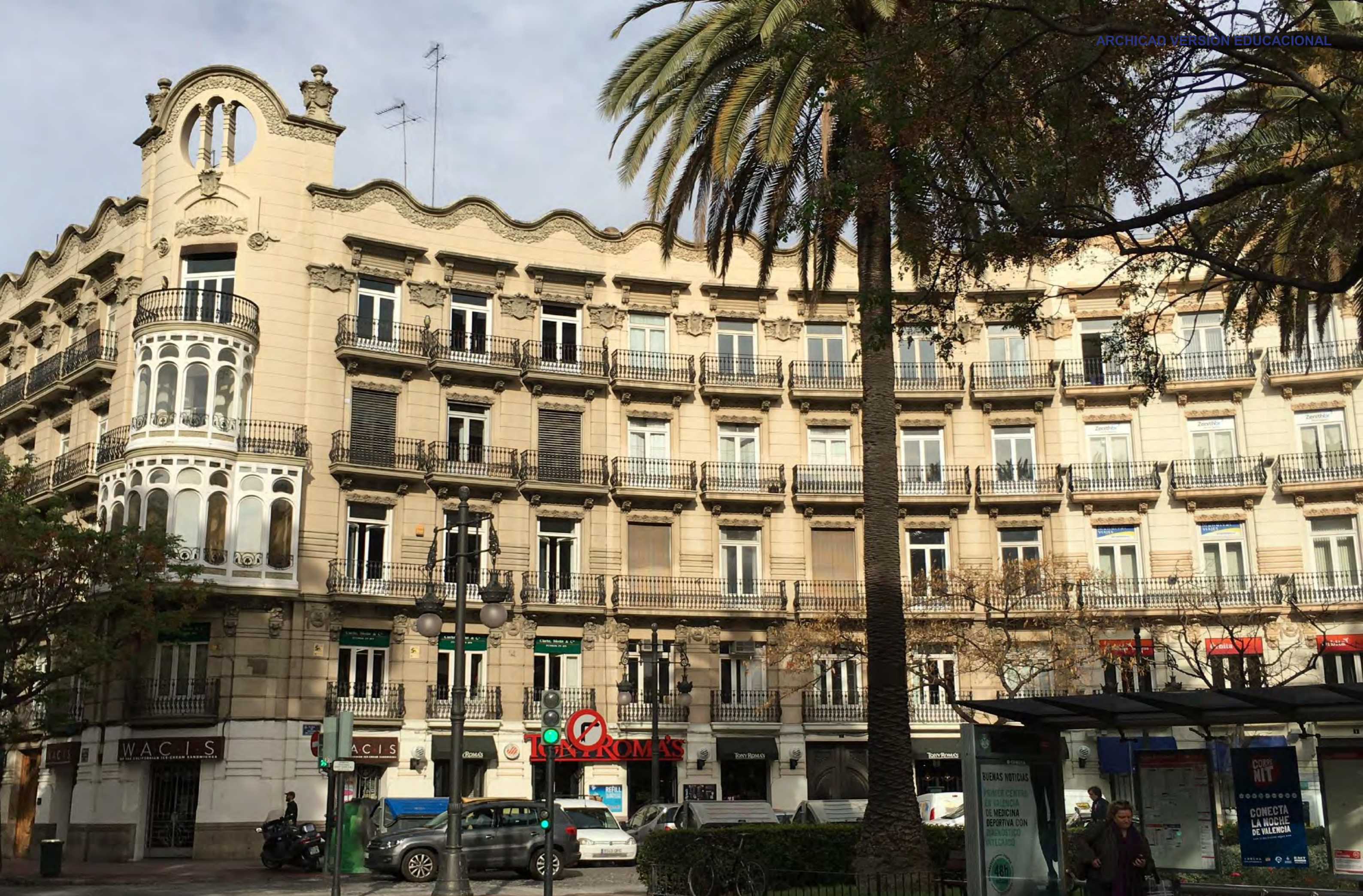
3 ESTADO ACTUAL (FASE 2)
