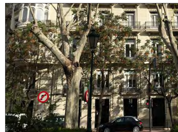
Imagen 48. Fachada Gran Vía Marqués del Turia N°65
