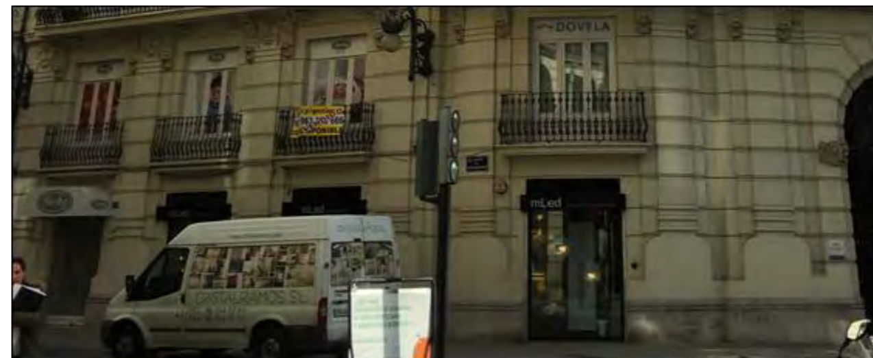
Imagen 46. Fachada C/ Conde de Salvatierra edificio Chapa n°65
