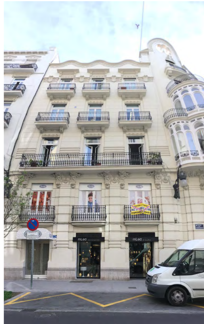
Imagen 80. Fachada C/Conde Salvatierra edificio Chapa n°65
