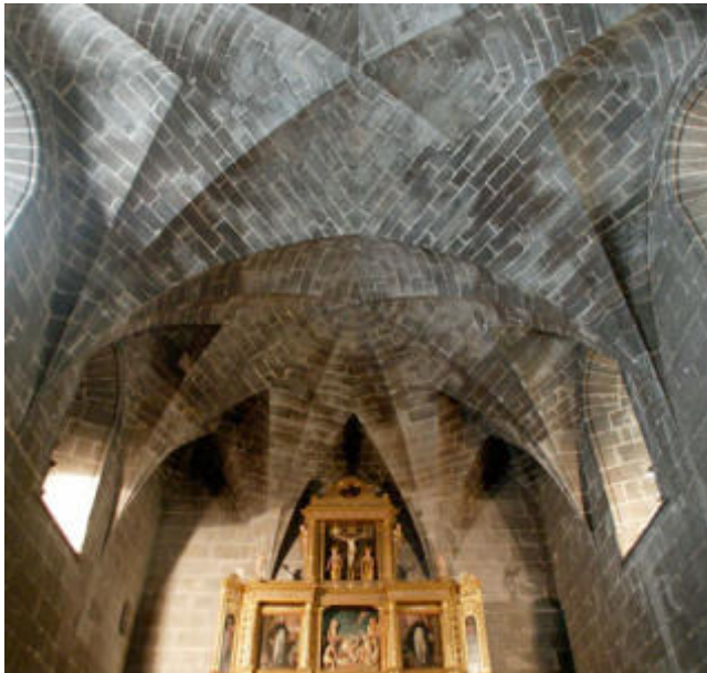
Figura 74. Bóveda de la Capilla Real. 2016. Web: levante-emv.com
