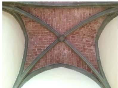
Figura 37. Bóveda de la capilla. 2016. Fotografía del autor.
