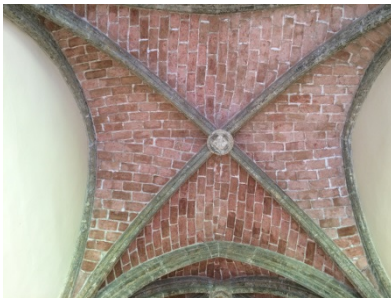
Figura 34. Bóveda de la capilla. 2016. Fotografía del autor.
