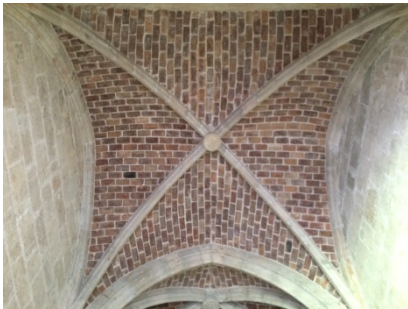
Figura 52. Bóveda. 2016. Fotografía del autor.
