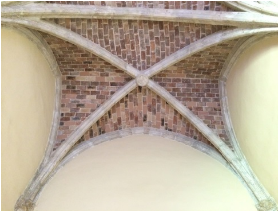
Figura 49. Bóveda. 2016. Fotografía del autor.
