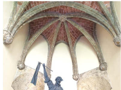
Figura 35. Bóveda de la capilla. 2016. Fotografía del autor.
