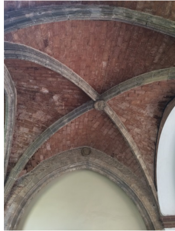
Figura 24. Bóveda de crucería que cubre el arco de la capilla. 2016. Fotografía del autor.
