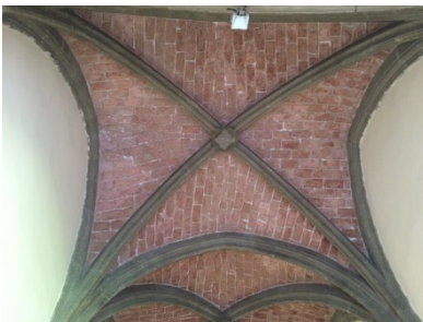
Figura 38. Bóveda de la capilla. 2016. Fotografía del autor.
