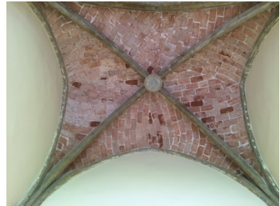
Figura 32. Bóveda de crucería. 2016. Fotografía del autor.
