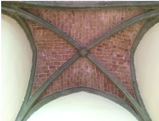
Figura 70. Imagen de un tramo de la bóveda de crucería de la nave del Claustro. 2016. Fotografía del autor.
