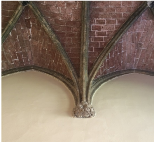
Figura 71. Bóveda de crucería, donde se muestra la ménsula desde donde nacen los nervios y la intersección de dos tramos. 2016. Fotografía del autor.
