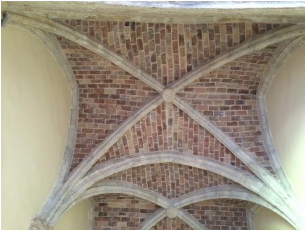
Figura 48. Bóveda. 2016. Fotografía del autor.
