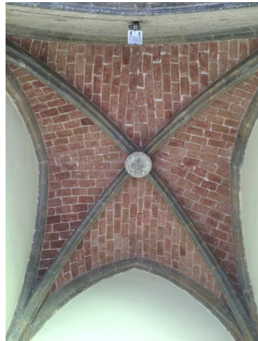
Figura 39. Bóveda de la capilla. 2016. Fotografía del autor.
