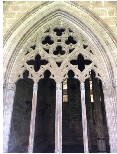
Figura 53. Arco apuntado con parteluces iluminando la Sala desde el Claustro Mayor. 2016. Fotografía del autor.
