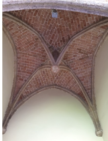
Figura 26. Clave central colgante de la bóveda de crucería. 2016. Fotografía del autor.
