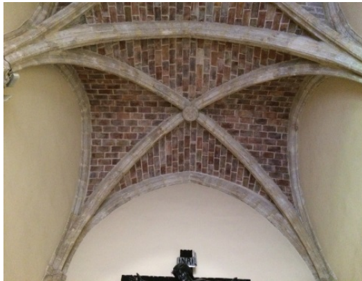
Figura 45. Bóveda de la capilla. 2016. Fotografía del autor.
