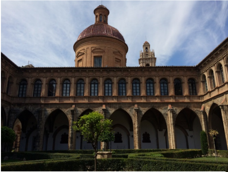
Figura 17. Claustro Mayor con vistas a la iglesia. 2016. Fotografía del autor.
