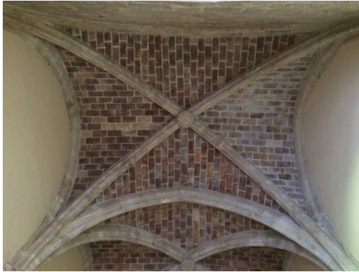
Figura 44. Vista cenital de la bóveda. 2016. Fotografía del autor.
