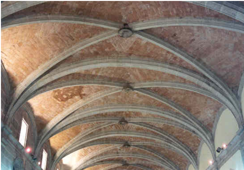
Figura 75. Bóveda del Refectorio. 2016. Web: bovedasvalencianas.blogs.upv.es
