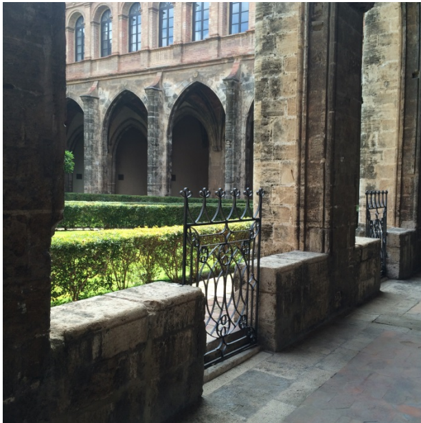
Figura 65. Imagen mostrando la disposición de los sillares. 2016. Fotografía del autor.
