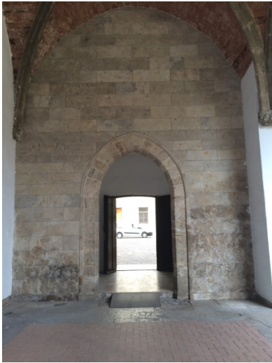
Figura 67. Muro visto y parte del muro revestido. 2016. Fotografía del autor.
