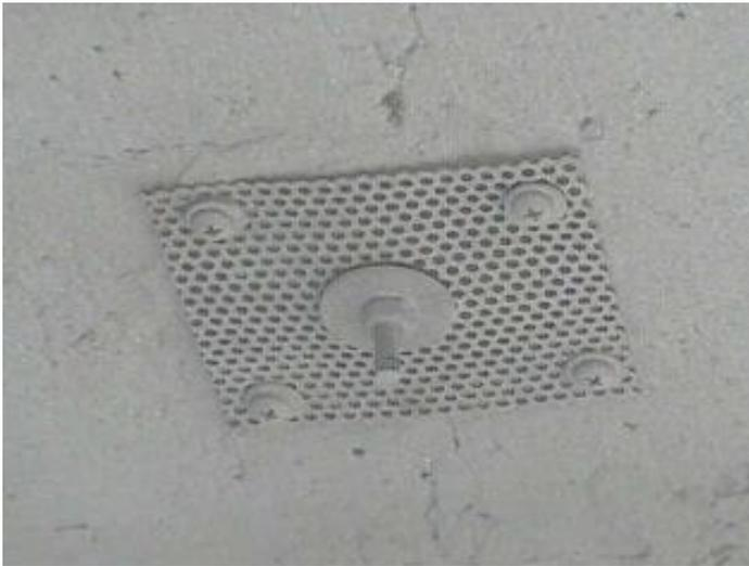
*Figura 27. Fotografía de detalle de conexión de ánodo en forma de revestimiento exterior de aleación de Aluminio-Zinc-Indio.*
