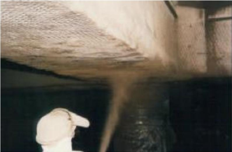
*Figura 30. Fotografía de ánodo de malla de Titanio para corriente impresa encapsulado con hormigón proyectado.*
