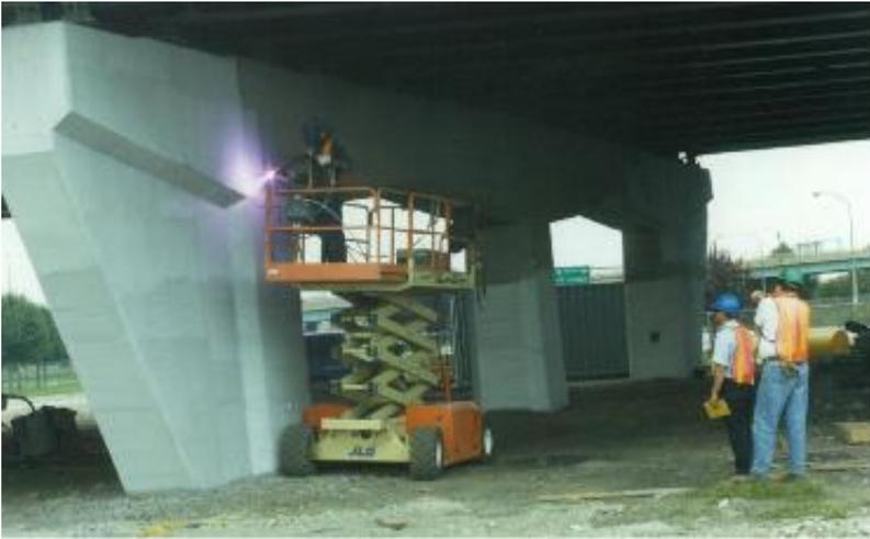
Figura 28. Fotografía de aplicación de ánodo de sacrificio Aluminio-Zinc-Indio.
