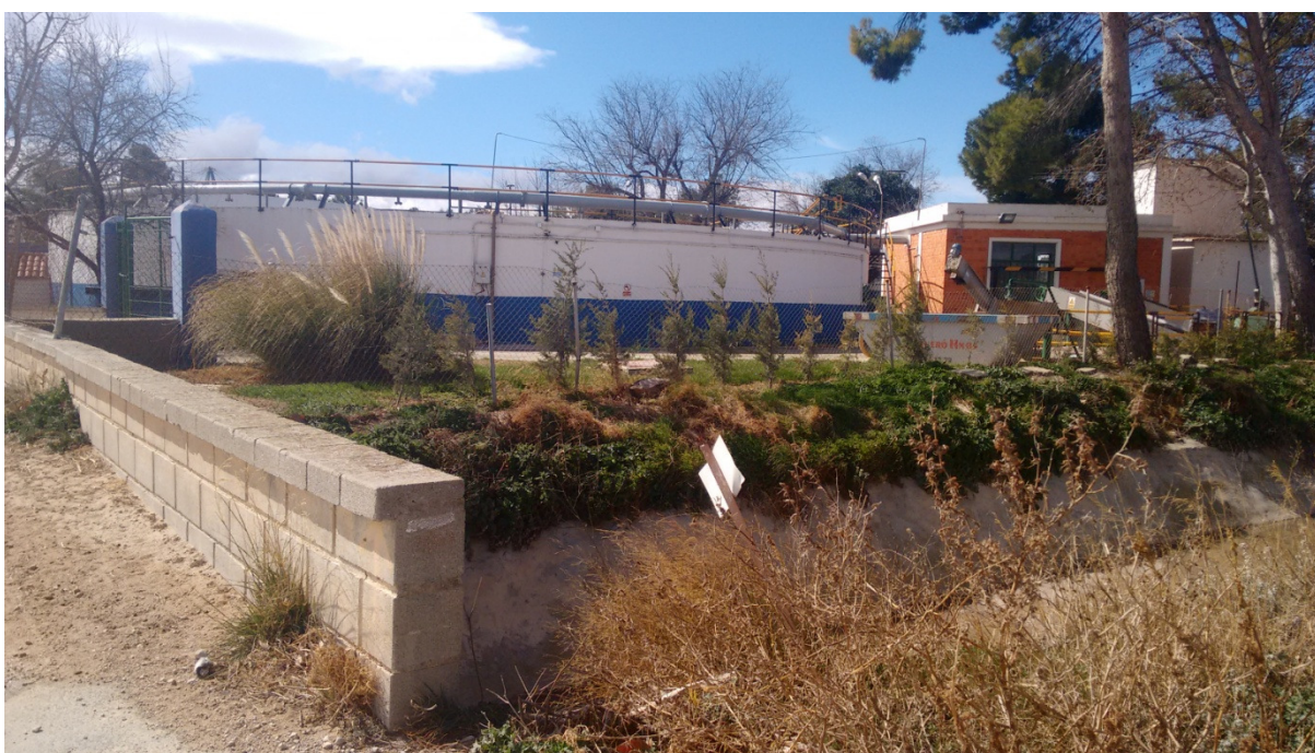
Foto 15: EDAR de Almansa, en primer plano el decantador primario y caseta de control
