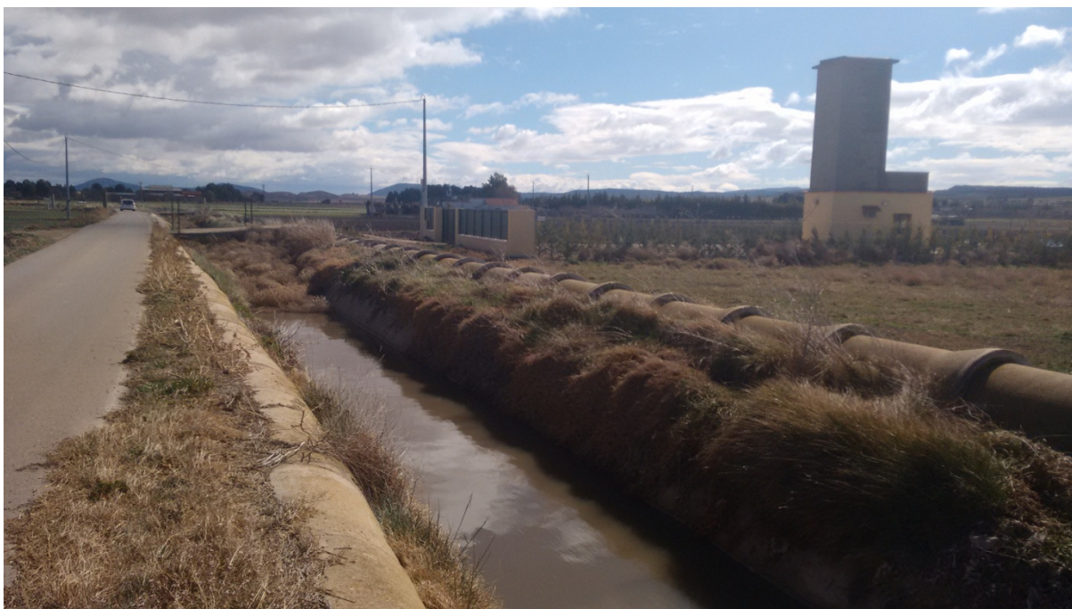
Foto 14: Vista de la Acequia del Saladar y conducción paralela que recoge las aguas residuales de Almansa en dirección a la estación depuradora
