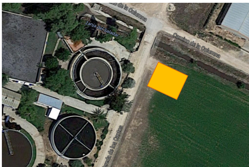
Fig. 28. Ubicación de la estación de bombeo (PNOA)
