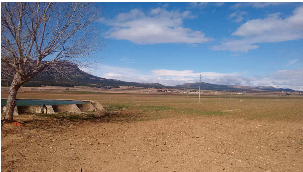
Foto 12: Punto previsto de ubicación de la salida del bombeo procedente la EDAR.
