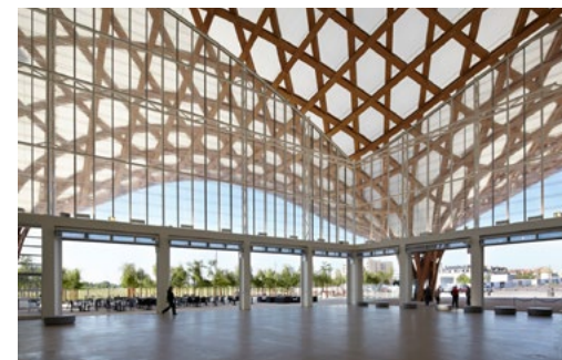
Figura 55. Imagen del vestíbulo y la cubierta desde el interior. Didier Boy de la Tour. 2010
