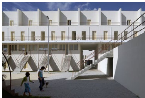
Figura 18. Viviendas sociales en Bouça, Oporto (Portugal). Proyecto: Álvaro Siza Vieira. Imagen: Duccio Malagamba. 2008
