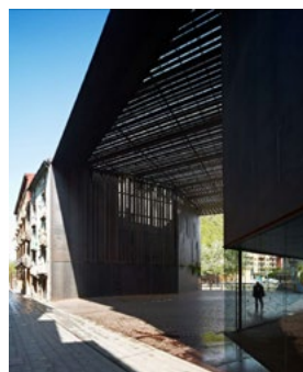
Figura 29. Imagen del acceso desde calle. RCR Arquitectes. 2014
