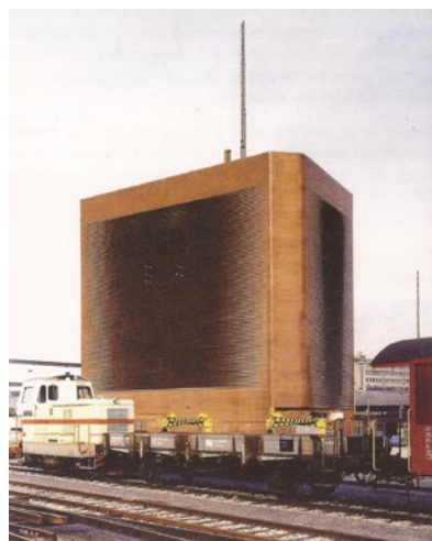
Figura 17. Central Signal Box Basel. Proyecto: Herzog & de Meuron. Imagen: Thomas Ruff. 1995
