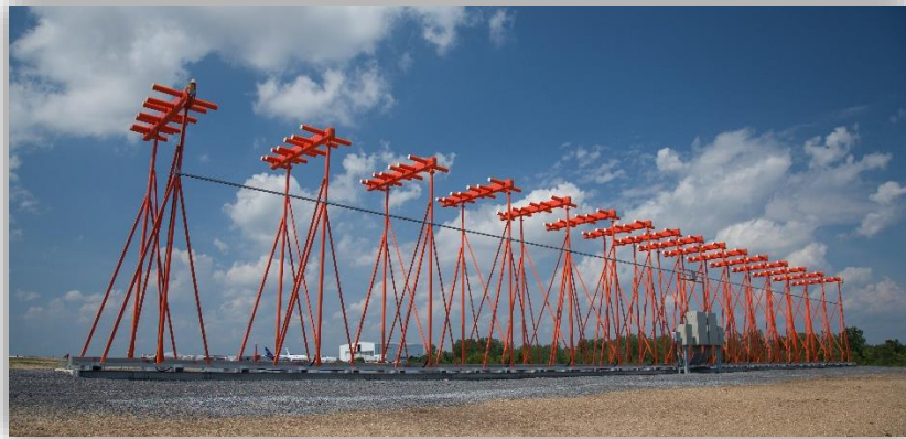
Ilustración 31: Infraestructura de un ILS
