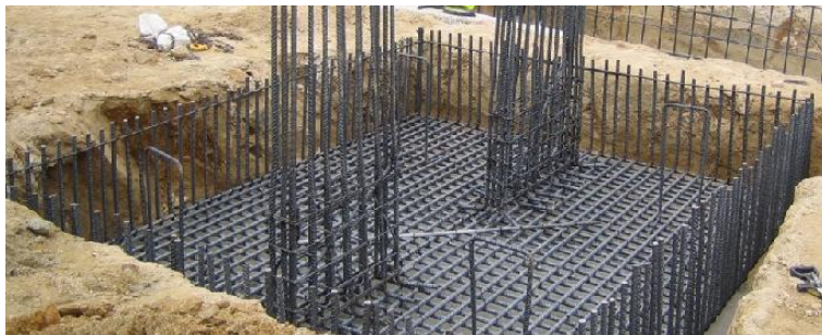
Figura 3. Esquema (imatge de dalt) i fotografia (imatge de baix) d'una biga de fonamentació.
