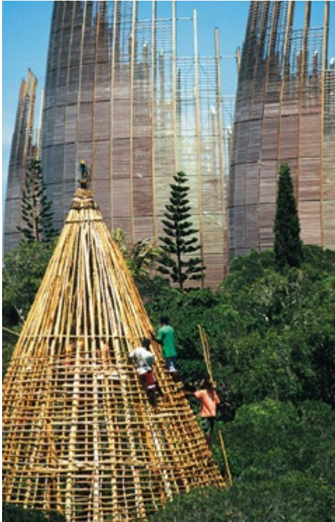
Figura 58. Similitud entre la cabaña tradicional y el edificio
