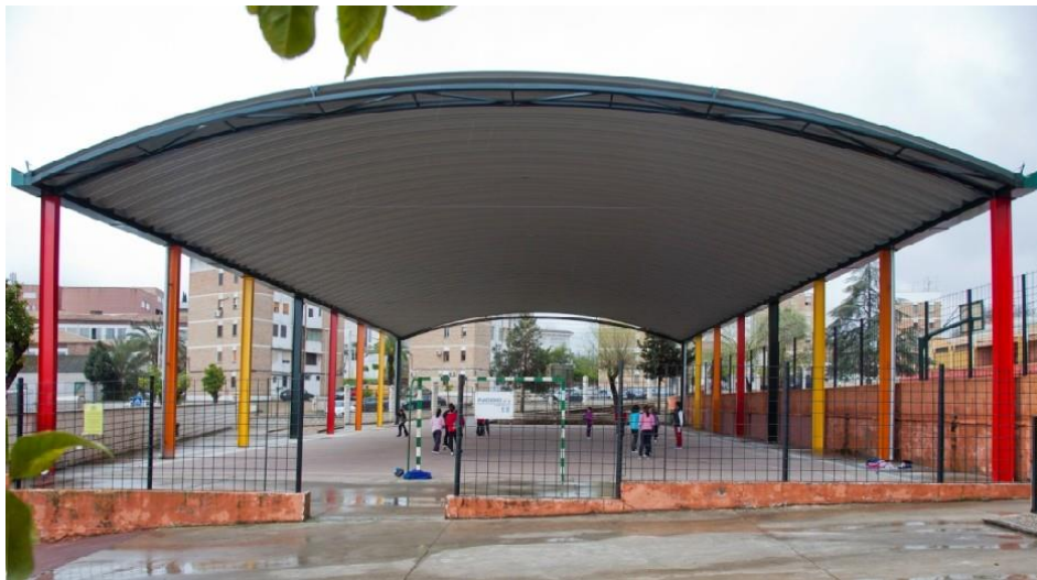
4 Estructura y Cubierta para pista polideportiva, de APIMET
