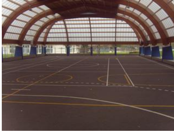
3 Pista deportiva en la localidad de Orozko
