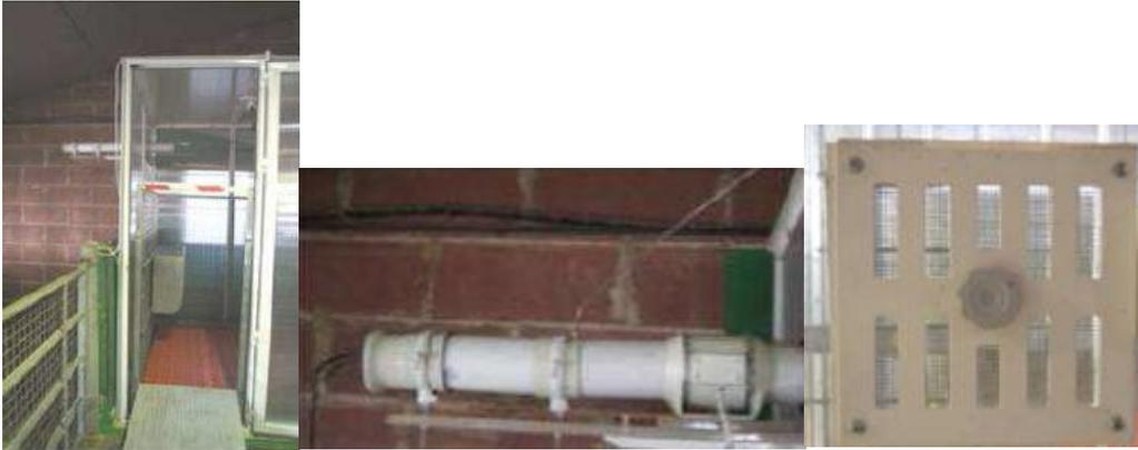
**Figura 10.** Comedero, tubo de extracción y entrada de aire
