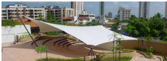
Figure 6: Membrane roof of the Memorial dos Povos of Belém do Pará.
