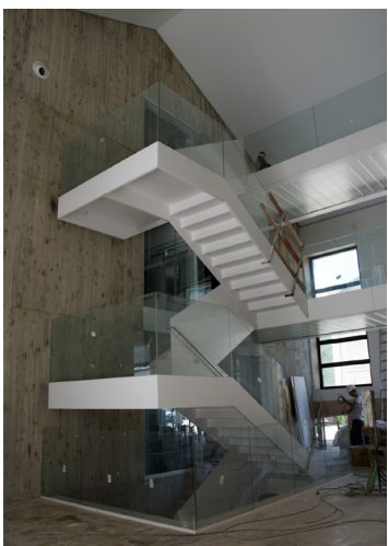
Figura 18. Escalera acceso al piso superior en la nave norte y vista general del interior.
