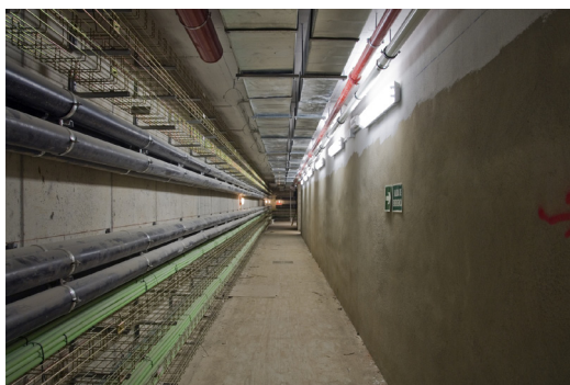
Figura 7. Anillos de instalaciones en los nuevos sótanos.
