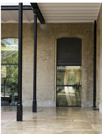
Figura 11. Apertura hasta el suelo de los huecos recayentes a los patios.
