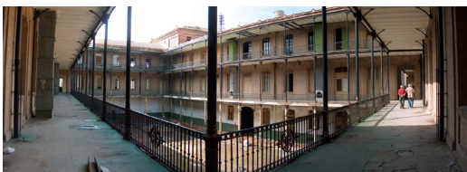
Figura 16. Estado de los patios durante la intervención.
