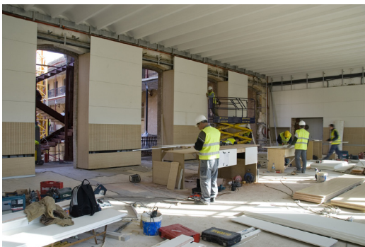
Figura 9. Interiores de las naves, colocando los paneles de revestimiento.
