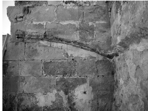
Huella de una bóveda tabicada dispuesta entre los contrafuertes del dormitorio del convento de Santo Domingo de Xàtiva (fines del siglo XIII).
