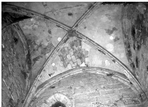
Detalle de la bóveda tabicada de una capilla lateral de la iglesia de San Martín de Valencia (Ca. 1372). Fotografía Carlos Campos.
