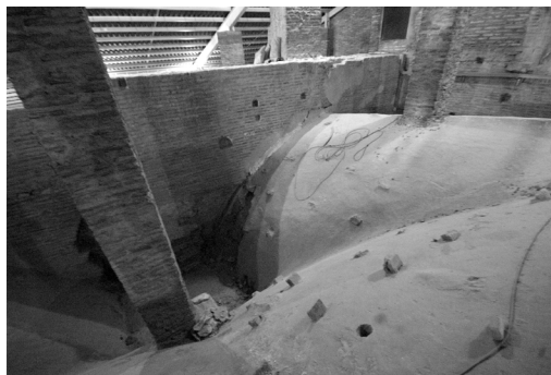
Bóvedas tabicadas de la nave central de la Seo de Zaragoza. (Ca. 1382). Foto Javier Ibañez.
