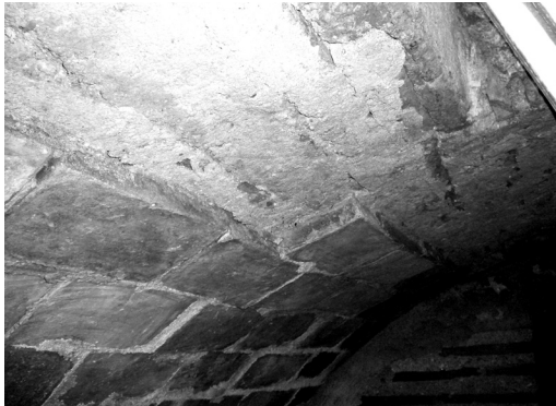
Detalle del estado actual de la bóveda de la cripta de la sala capitular del antiguo convento de Santo Domingo de Xàtiva (1329-1336). Una bóveda tabicada sirve de cimbra perdida a una bóveda de rosca.
