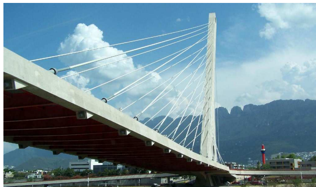
Ilustración 9. Puente atirantado Monterrey (México)
