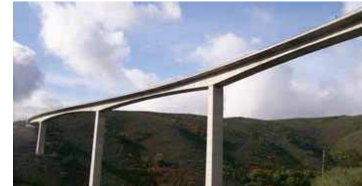
Ilustración 6. Puente pretensado de canto variable. Imagen Google
