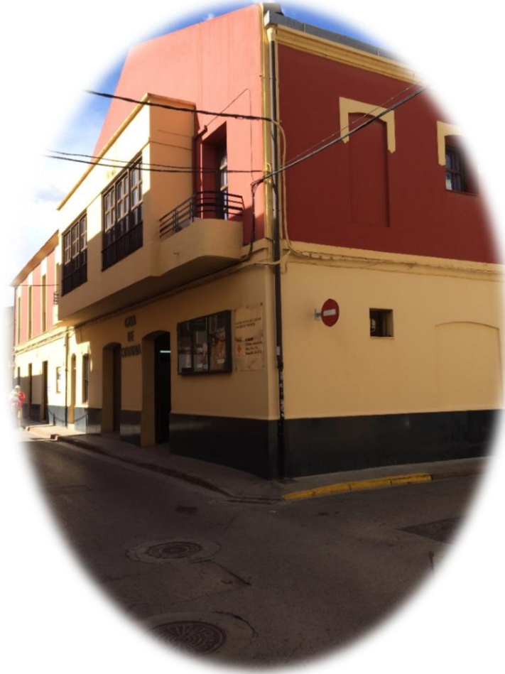
Ilustración 7. Esquina Fachada Principal.
