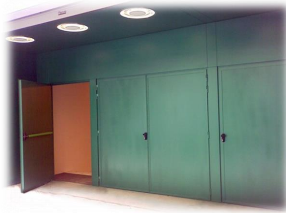
Ilustración 171. Ejemplo Puerta acústica exterior de hoja doble y simple.
