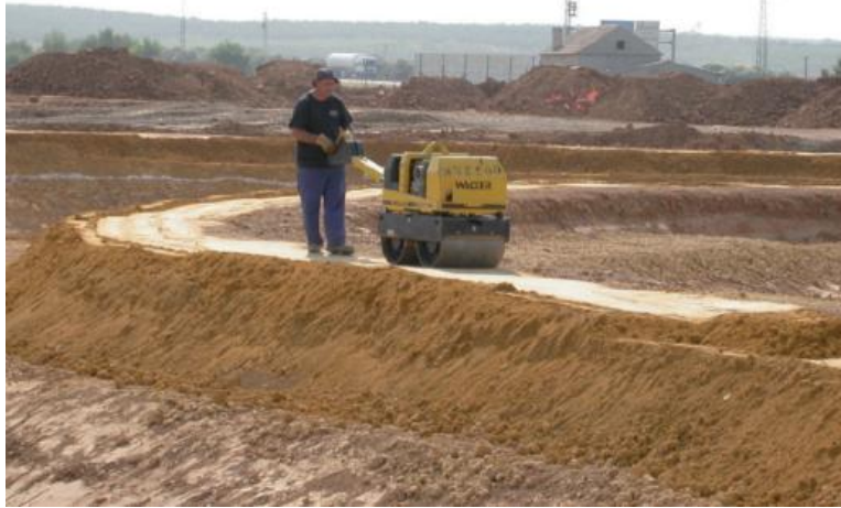
Figura III. 25: Compactación de la coronación de la laguna facultativas y de maduración (Manual de Tecnologías no Convencionales para la Depuración de Aguas Residuales).
