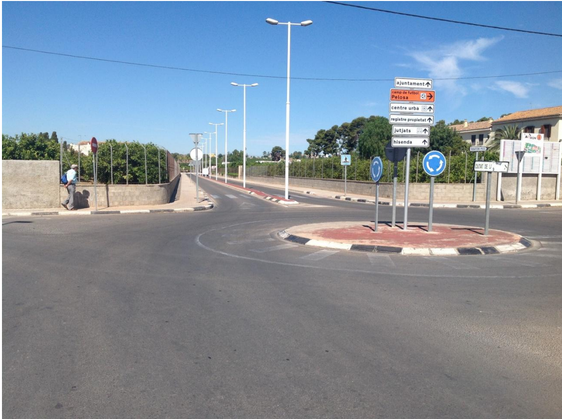
Figura I. 10: Imagen de la rotonda donde se ubica el cajero (con su respectivo aliviadero) donde se comunican el colector de la Defensa que viene de Norte a Sur en esta imagen y el colector D 700 mm del Este de la imagen (visita a campo).
