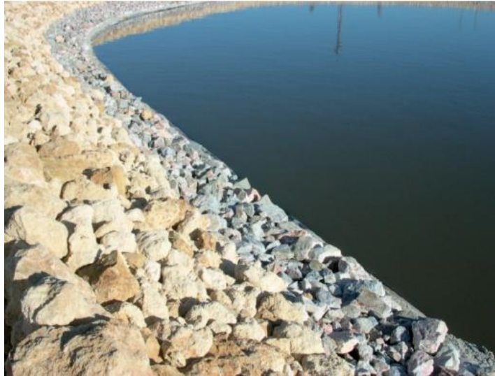
Figura III. 35: Llenado de una laguna de maduración (Manual de Tecnologías no Convencionales para la Depuración de Aguas Residuales).
