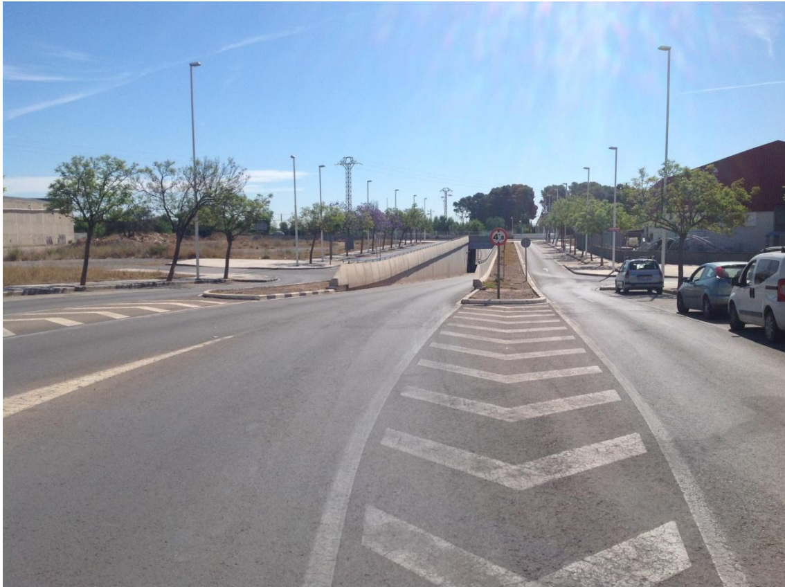
Figura I. 11: Imagen del túnel que comunica con el barranco del Carraixet (hacia el Norte) y por el cual pasará nuestro colector de la Defensa (viene del Sur); (visita a campo).
