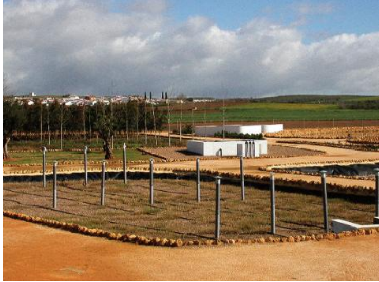
Figura III. 73: Evolución de la vegetación de un HAFSs tras su siega (20 Febrero 2006); (Manual de Tecnologías no Convencionales para la Depuración de Aguas Residuales).
