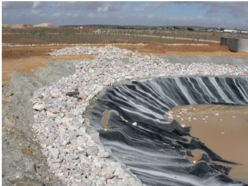
Figura III. 32: Encachado de los taludes de las lagunas facultativas y de maduración (Manual de Tecnologías no Convencionales para la Depuración de Aguas Residuales).
