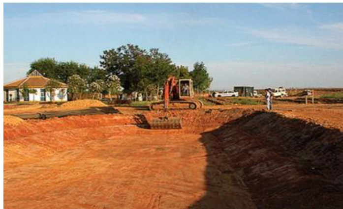
Figura III. 51 Excavación del confinamiento de un Humedal artificial (Manual de Tecnologías no Convencionales para la Depuración de Aguas Residuales).
