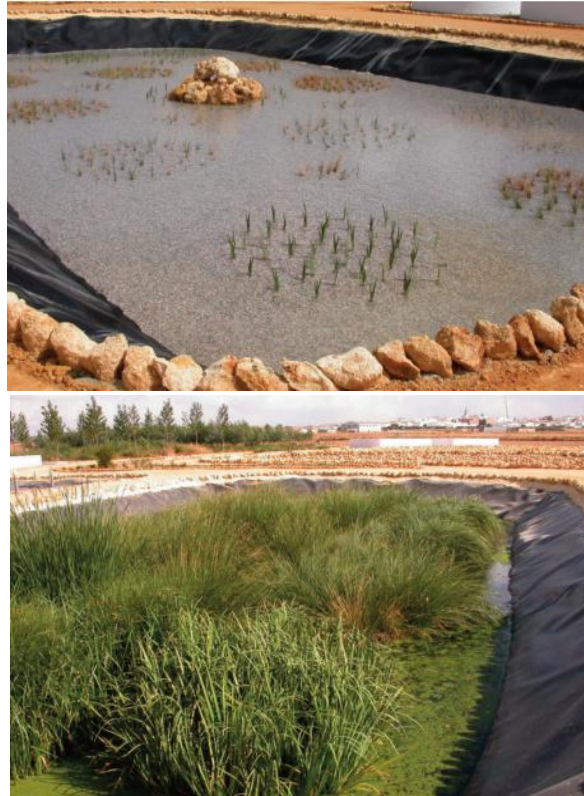
Figura III. 66: Aspecto de un humedal de flujo superficial recién plantado y al año de su plantación (Manual de Tecnologías no Convencionales para la Depuración de Aguas Residuales).
