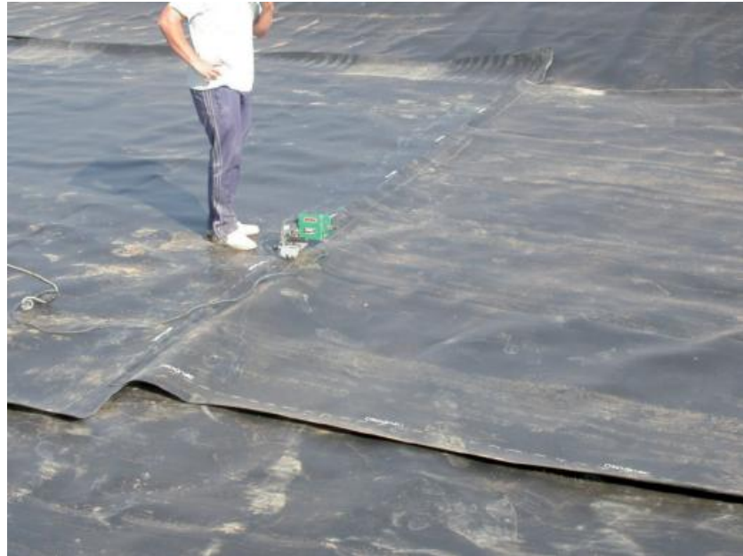
Figura III. 29: Termosoldado de las láminas de PEAD en lagunas facultativas y de maduración (Manual de Tecnologías no Convencionales para la Depuración de Aguas Residuales).
