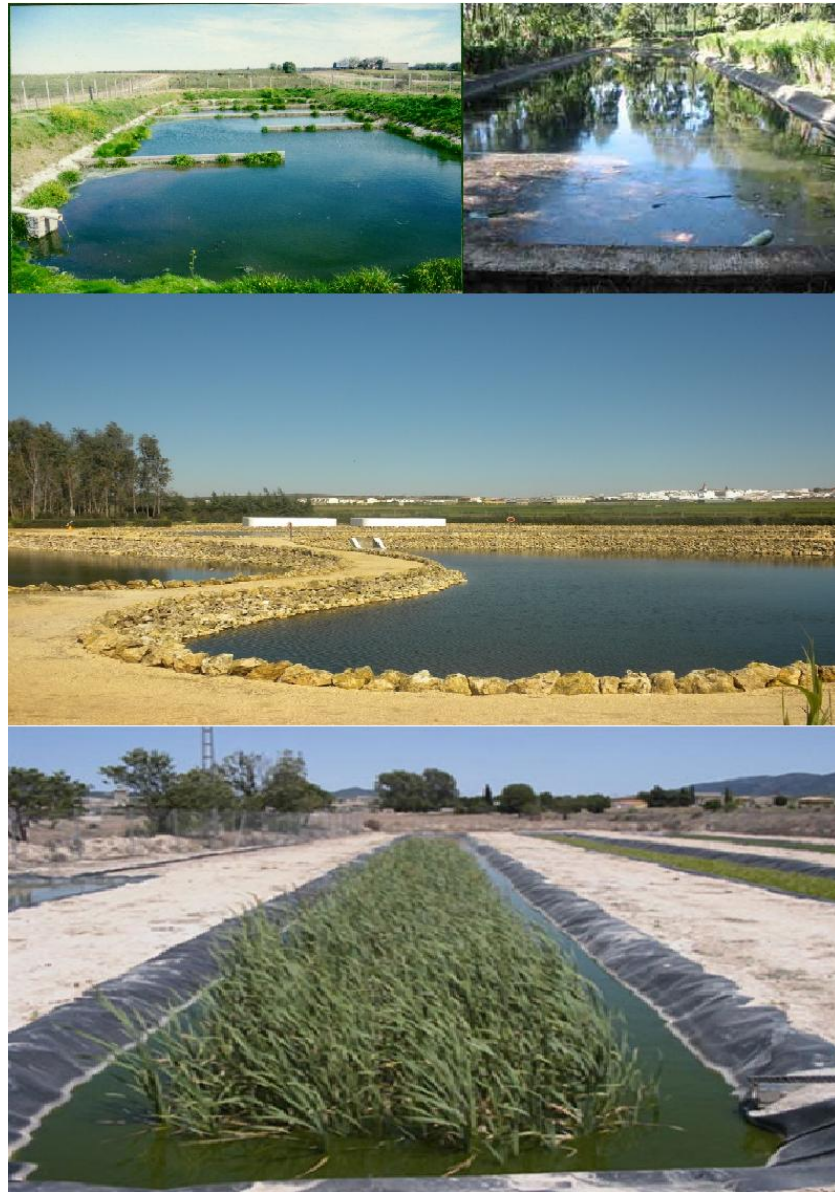
Imágenes de los tres tipos de lagunaje y humedales artificiales (Imágenes de Google).
