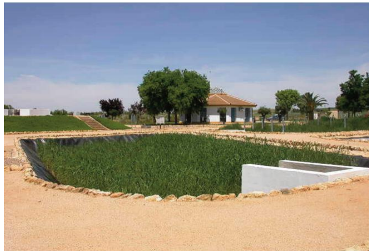
Imagen de la entrada de agua en un humedal (Manual de Tecnologías no Convencionales para la Depuración de Aguas)
