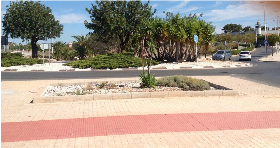
Figura I. 8: Imagen de la rotonda donde se comunican los colectores, D 1400 mm (calle Oeste) y D1000 mm (calle Este). Comienzo del colector de la Defensa con su correspondiente aliviadero (Cajero Defensa) ;(visita a campo).
