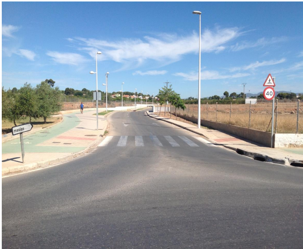
Figura I. 6: Imagen de la calle 130 por donde baja el colector D 1400 mm que recoge gran parte de las aguas pluviales y las comunica con el colector de la Defensa (visita a campo).
