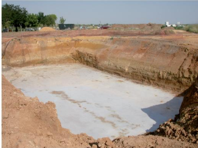
Figura III. 13: Hormigón de limpieza en el fondo de la excavación de una laguna anaerobia (Manual de Tecnologías no Convencionales para la Depuración de Aguas Residuales).
