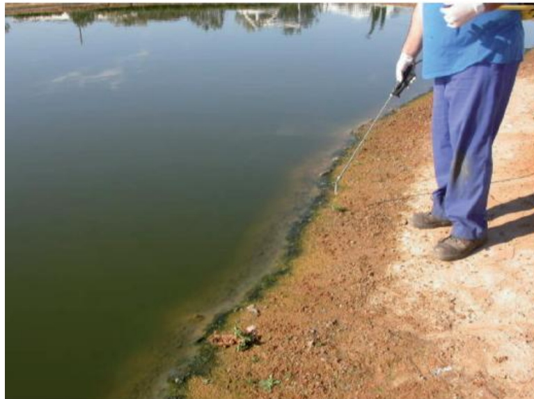
Figura III. 39: Eliminación mediante herbicida de la vegetación de los taludes de las lagunas (Manual de Tecnologías no Convencionales para la Depuración de Aguas Residuales).
