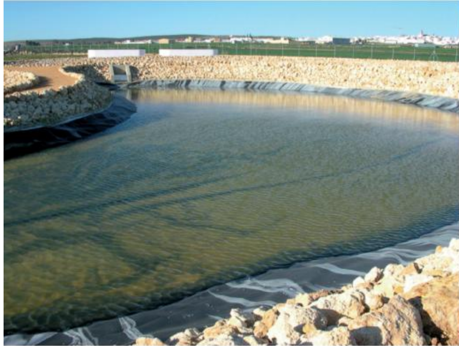
Figura III. 34: Llenado de una laguna facultativa (Manual de Tecnologías no Convencionales para la Depuración de Aguas Residuales).
