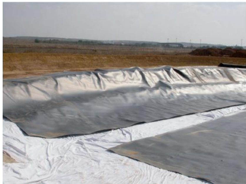
Figura III. 28: Colocación de la lámina plástica de PEAD en lagunas facultativas y de maduración (Manual de Tecnologías no Convencionales para la Depuración de Aguas Residuales).
