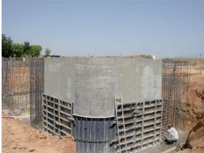
Figura III. 19: Retirada del encofrado en una laguna anaerobia (Manual de Tecnologías no Convencionales para la Depuración de Aguas Residuales).
