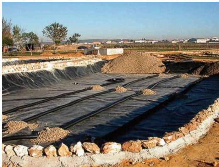
Figura III. 61: Conjunto de tuberías de drenaje para la evacuación de los efluentes depurados en un HAFSs vertical (Manual de Tecnologías no Convencionales para la Depuración de Aguas Residuales).
