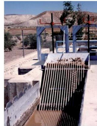
Figura III. 7: Desbaste con reja de limpieza manual (Manual de Tecnologías no Convencionales para la Depuración de Aguas Residuales).
