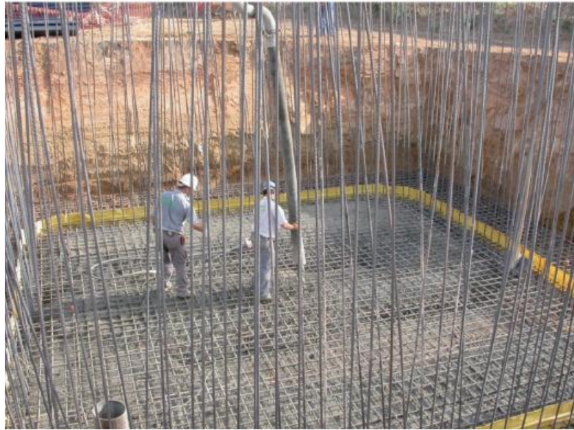
Figura III. 15: Hormigonado de la solera en una laguna anaerobia (Manual de Tecnologías no Convencionales para la Depuración de Aguas Residuales).
