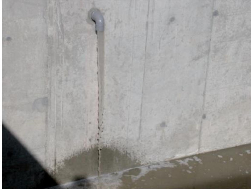
Figura III. 33: Llenado de una laguna anaerobia (Manual de Tecnologías no Convencionales para la Depuración de Aguas Residuales).
