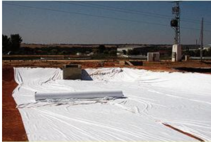
Figura III. 53: Colocación de una lámina de geotextil en un humedal artificial (Manual de Tecnologías no Convencionales para la Depuración de Aguas Residuales).
