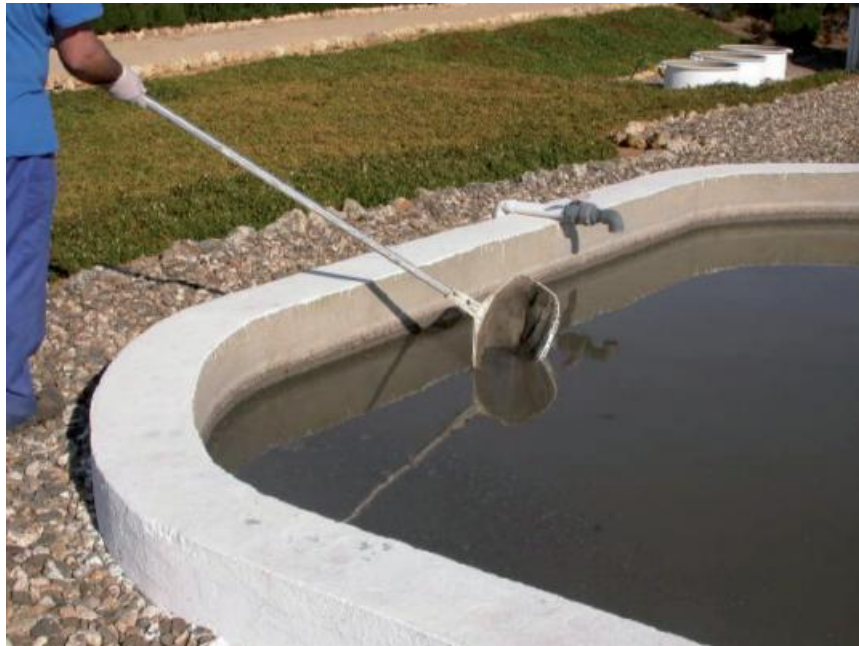
Figura III. 36: Retirada de flotantes en una laguna anaerobia.
