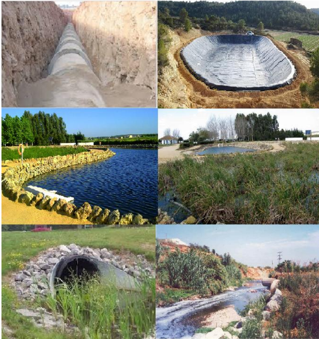
Imágenes de los colectores, lagunaje anaerobio, lagunaje facultativo, lagunaje de maduración, humedales artificiales, colector de salida y ecosistemas formados (Imágenes de Google).
