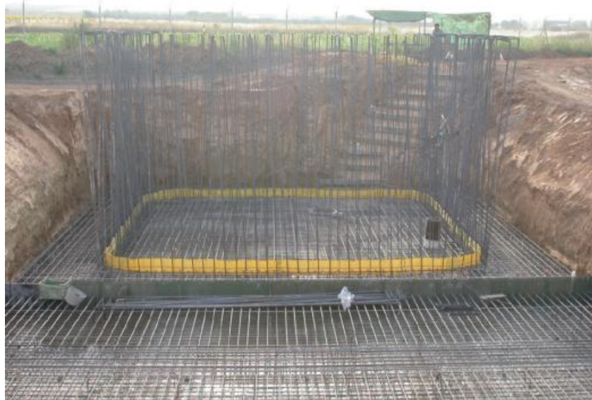
Figura III. 14: Colocación de la armadura en una laguna anaerobia (Manual de Tecnologías no Convencionales para la Depuración de Aguas Residuales).
