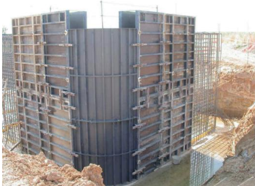
Figura III. 17: Encofrado en una laguna anaerobia (Manual de Tecnologías no Convencionales para la Depuración de Aguas Residuales).
