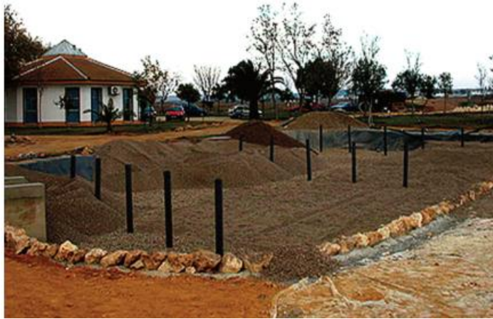
Figura III. 64: Colocación de las chimeneas de ventilación en un HAFSs vertical (Manual de Tecnologías no Convencionales para la Depuración de Aguas Residuales).
