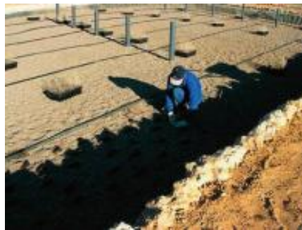
Figura III. 68: Distribución de las bandejas con plantas de vivero para lograr una plantación uniforme del humedal (Manual de Tecnologías no Convencionales para la Depuración de Aguas Residuales).
