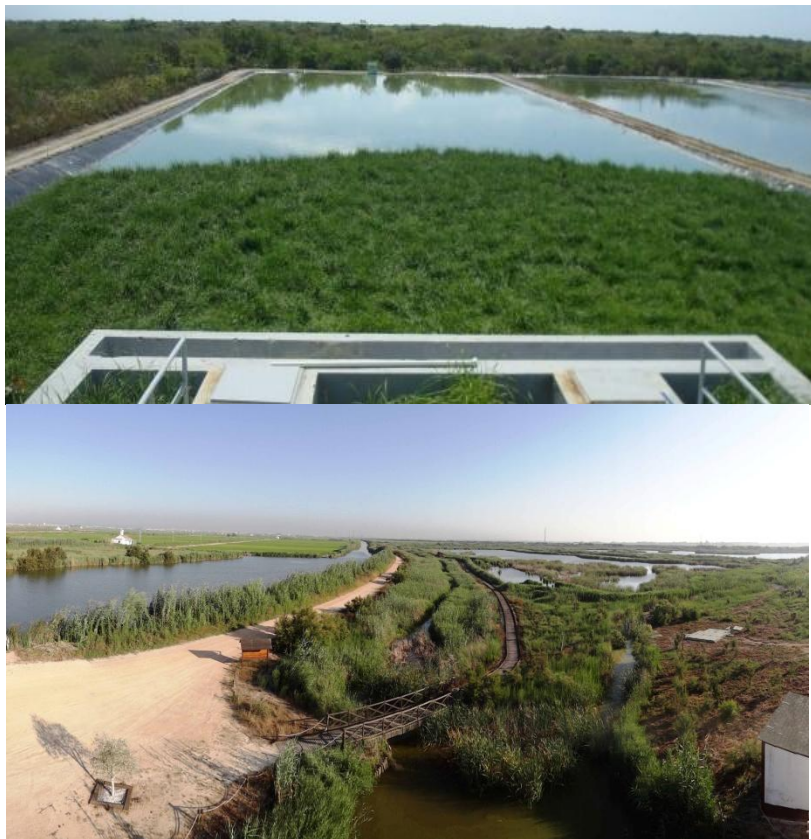
Imágenes de un sistema de lagunaje y de humedales artificiales (Imágenes Google).
