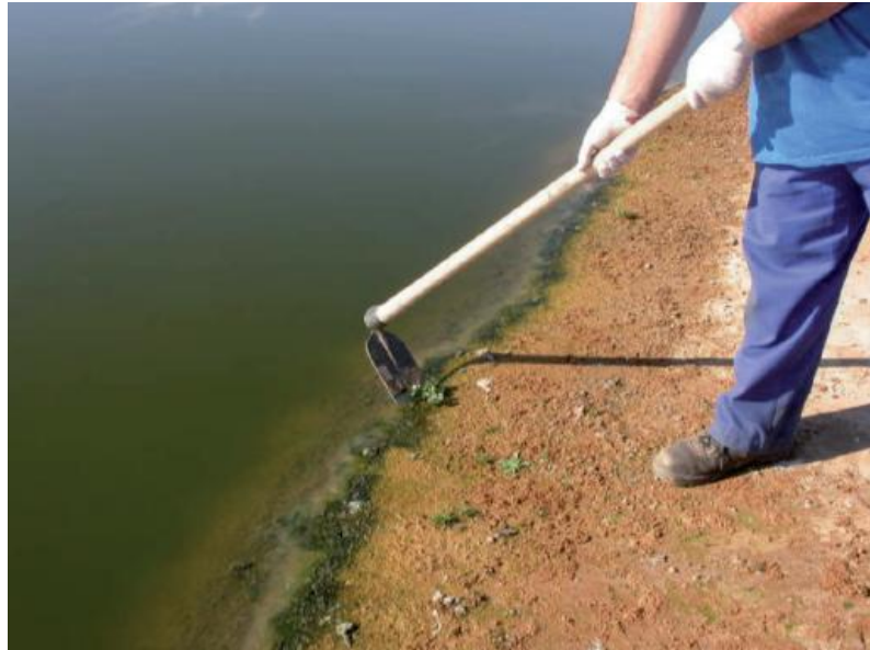
Figura III. 38: Eliminación manual de la vegetación de los taludes de las lagunas (Manual de Tecnologías no Convencionales para la Depuración de Aguas Residuales).
