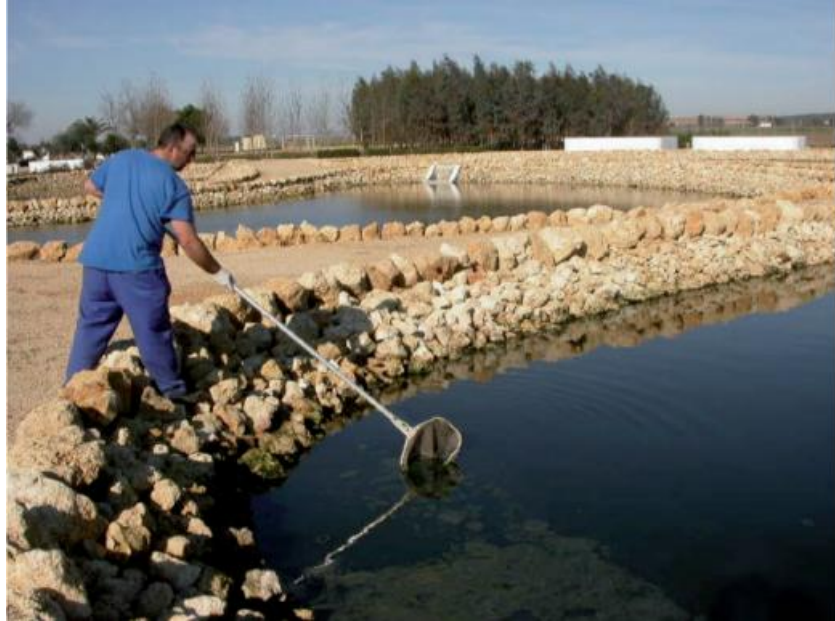
Figura III. 37: Retirada de flotantes en una laguna de maduración (Manual de Tecnologías no Convencionales para la Depuración de Aguas Residuales).
