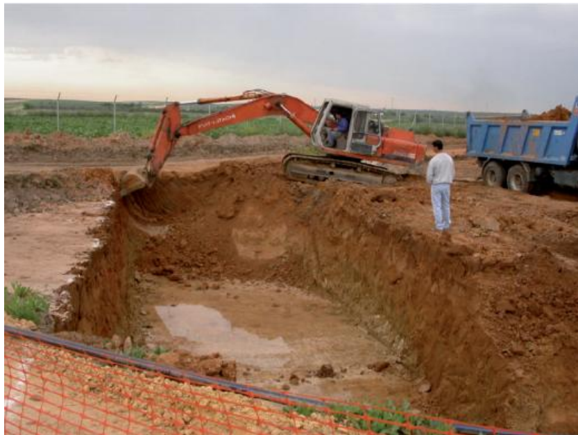
Figura III. 12: Excavación del confinamiento de una laguna anaerobia (Manual de Tecnologías no Convencionales para la Depuración de Aguas Residuales).
