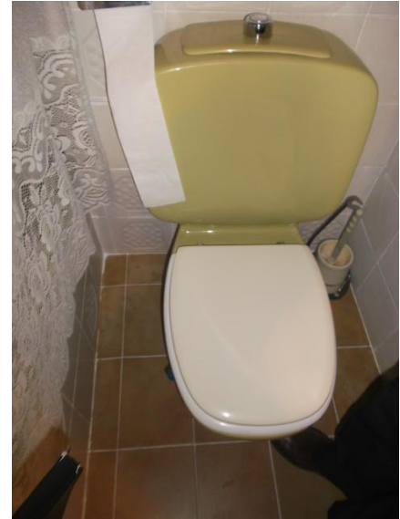
Ilustración 21. Ejemplo daños estéticos en sanitario por rotura de tapa/ Fuente propia
