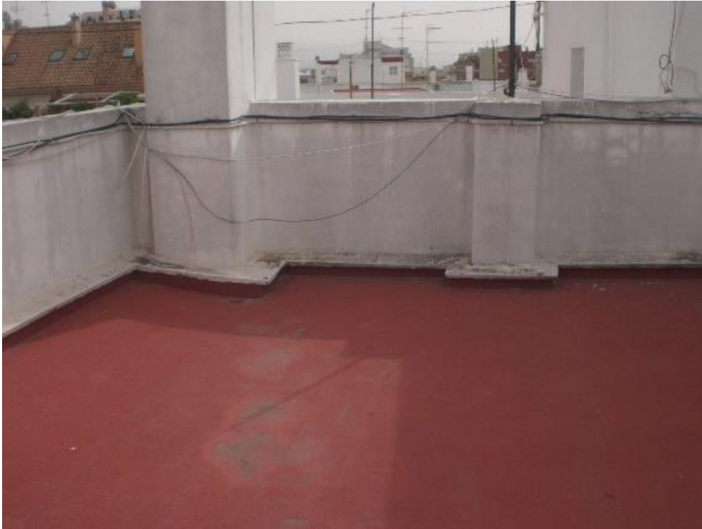
Ilustración 14. Ejemplo de cubierta con mantenimiento realizado/ Fuente propia
