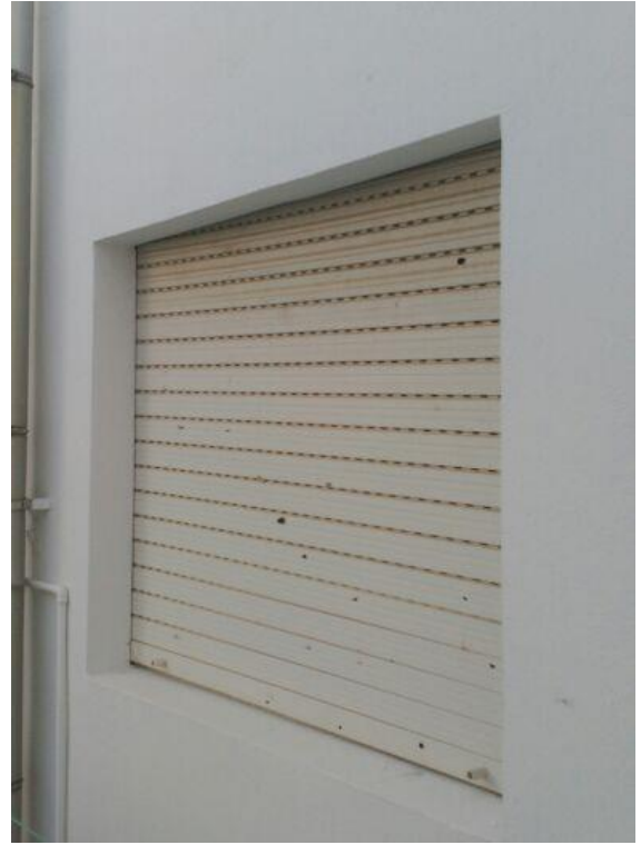
Ilustración 19. Ejemplo de elementos dañados por el pedrisco/ Fuente propia
