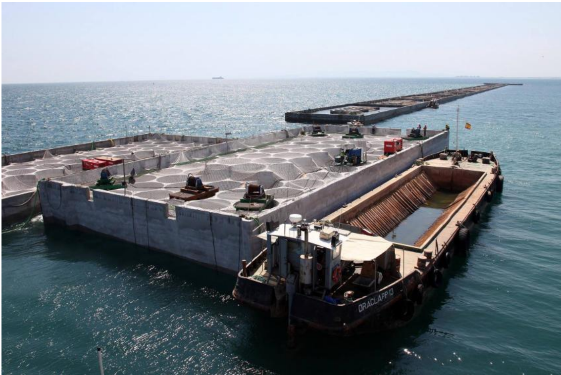
Figura 33. Dique de abrigo. Fondeo de cajones. Fuente: Las provincias
