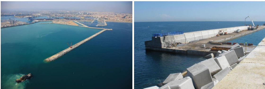
Figura 32. Dique de abrigo. Primera alineación. Dique en talud (izquierda) y dique vertical (derecha). Fuente: Las provincias
