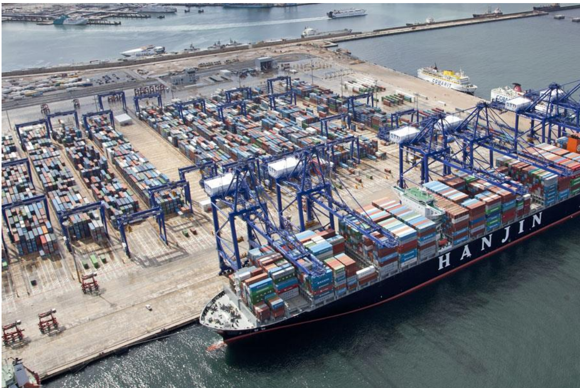
Figura 14. Vista aérea de la terminal APM Algeciras. Fuente: apba.es
