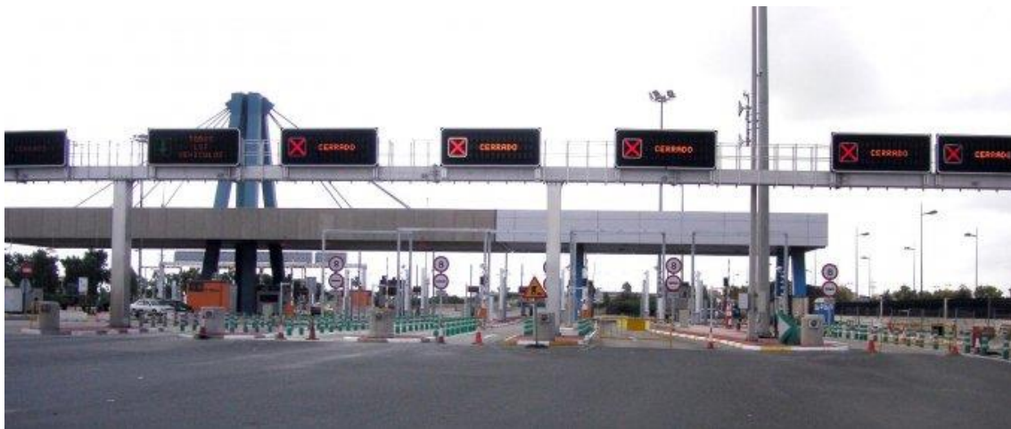
Figura 56. Puertas de acceso principal para camiones del Puerto de Valencia. Fuente: nauticajonkepa.wordpress.com
