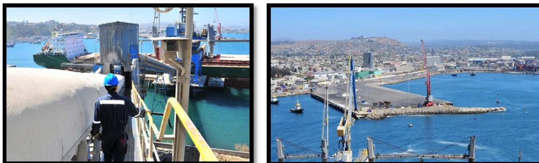
Ilustración 39: Ejemplo de infraestructura y equipos de la Terminal PUERTO PANUL
