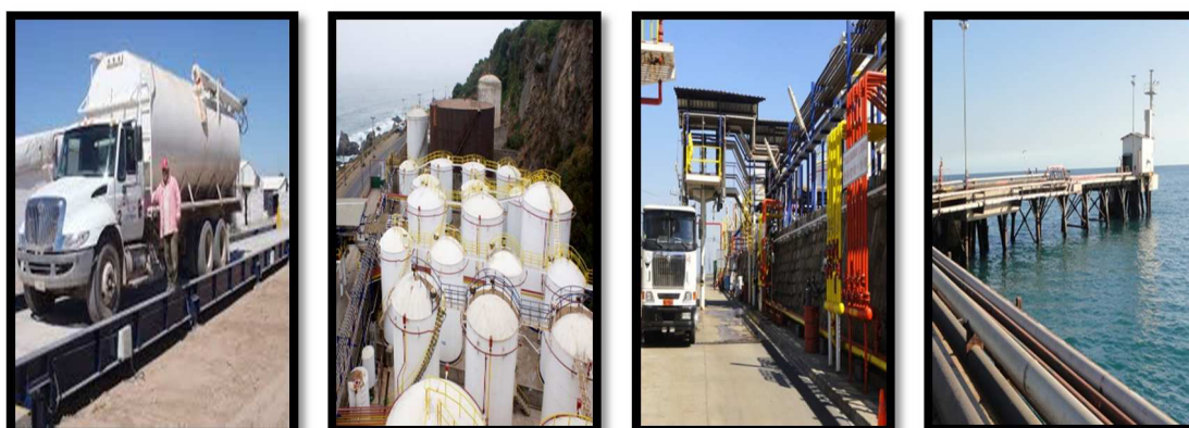
Ilustración 40: Ejemplo de infraestructura y equipos de la Terminal QC
