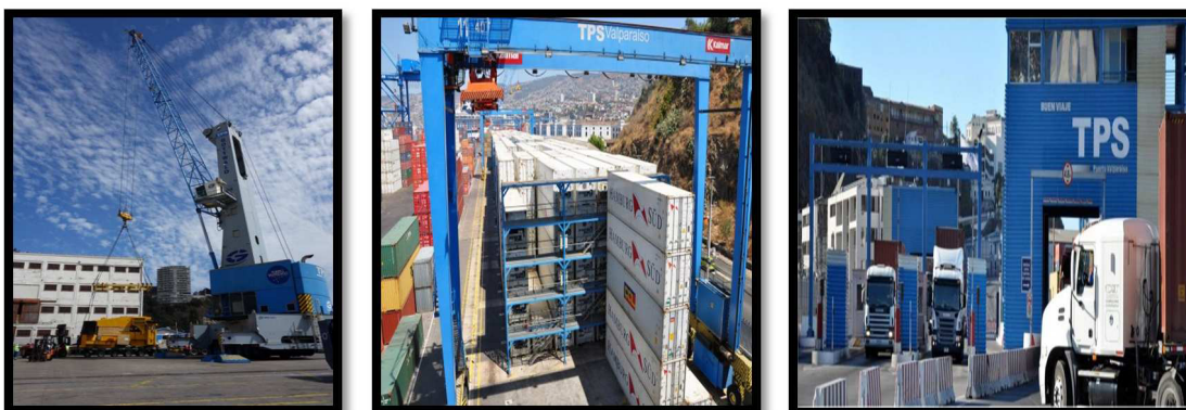
Ilustración 58: Ejemplos de infraestructuras y equipos de la terminal TIPS
