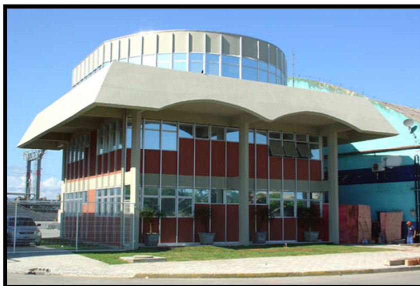
Ilustración 27: Edificio de emergencias médicas y mirador en el puerto de Paranaguá
