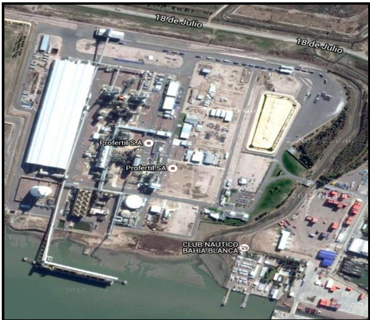
Ilustración 11: Vista aérea de las instalaciones de Profertil S.A.
