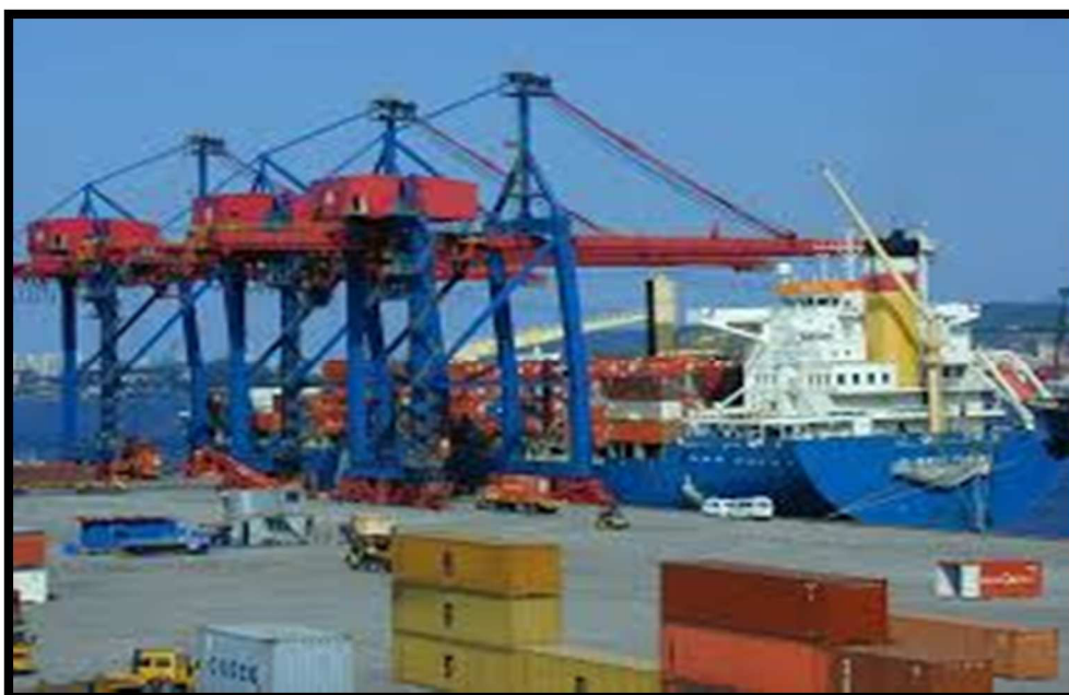
Ilustración 18: Ejemplo de las infraestructuras del Consorcio Santos Brasil.
