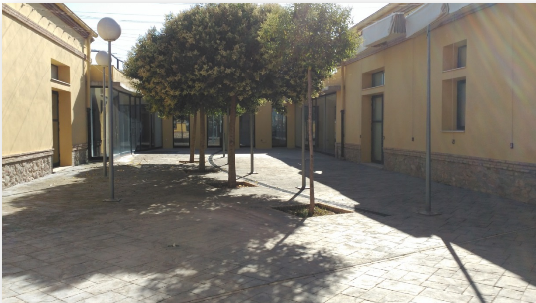
Figura 20. Entrada principal del matadero municipal de Moncada. 2016. Foto propia
